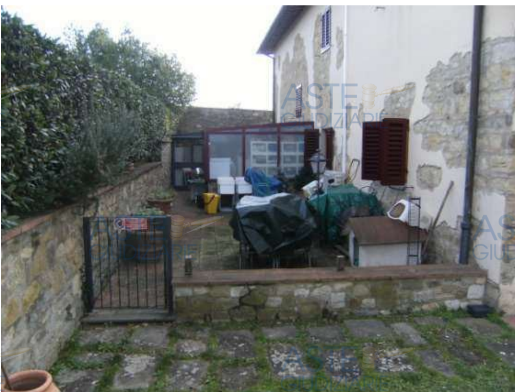
Vista facciata tergale - tratta da precedente visita effettuata da Geom. Romagnoli)
