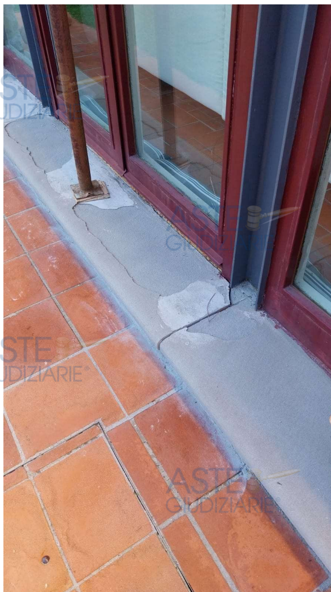
Vista rivestimento lesionato infisso esterno
