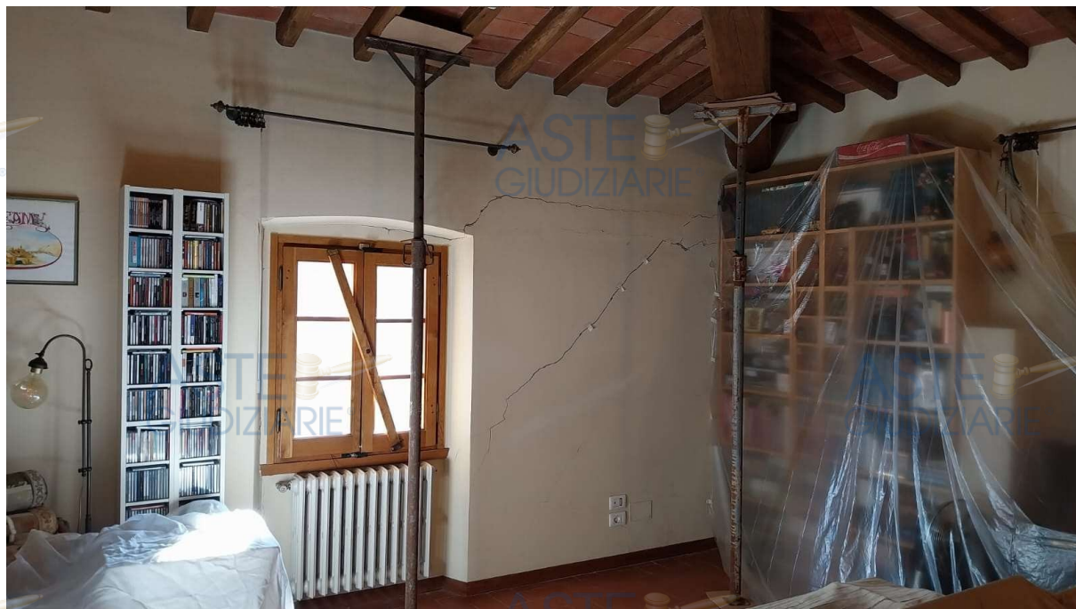
Vista interna locale piano primo zona spigolo esterno
