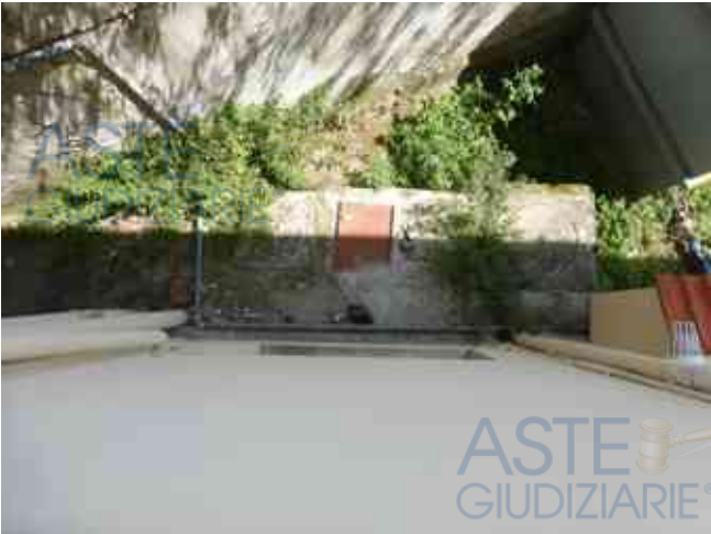
b - dettaglio fosse biologiche dalla finestra del locale 1
