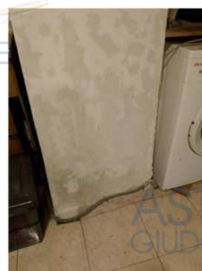
FOTO 24 umidità su struttura
