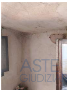
FOTO 51 dettaglio condensa
