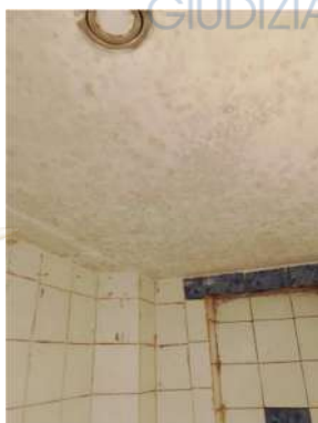
FOTO 31 condensa a soffitto
