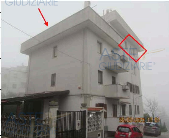
Foto n° 4: Vista prospettica del fabbricato condominiale da via della Fontanella ove è riscontrabile il terrazzo a livello ad uso esclusivo all'ultimo piano indicata con la freccia rossa nonché le finestre di affaccio, sempre , indicate con la riquadratura di colore rosso.
