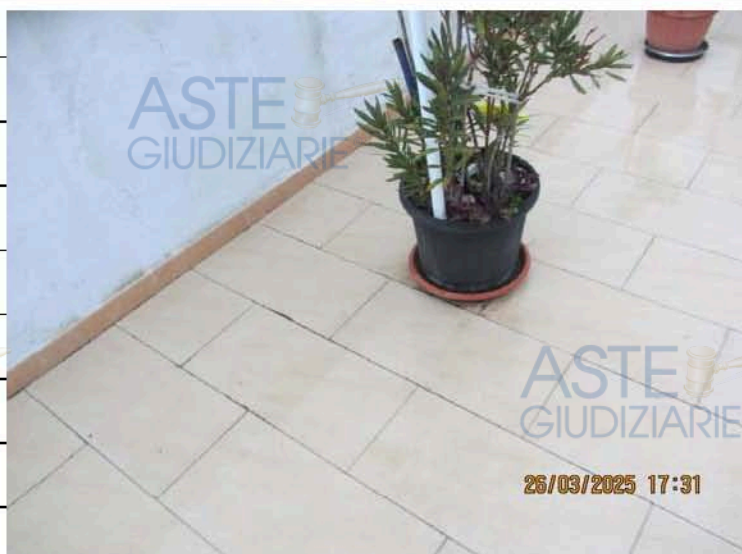
Foto n° 28: Vista particolareggiata della pavimentazione del terrazzo a livello ad uso esclusivo pertinenziale
