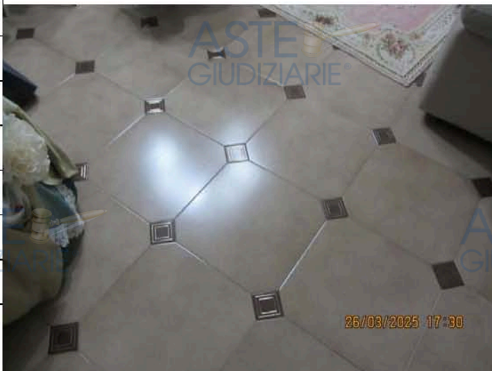
Foto n° 22: Vista particolare della pavimentazione rilevata all'interno dell'appartamento, con esclusione del vano bagno.
