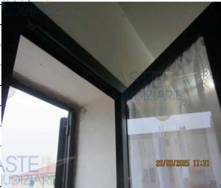
Foto n° 23: Vista particolare della tipologia degli infissi esterni.
