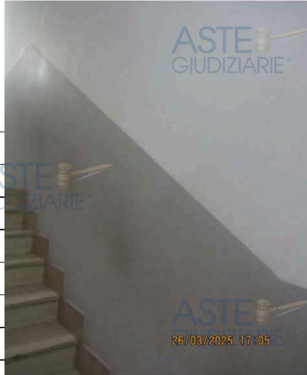
Foto n° 12: Vista di dettaglio della tipologia di finiture di dipintura delle pareti murarie del vano scala di ordinaria qualità.
