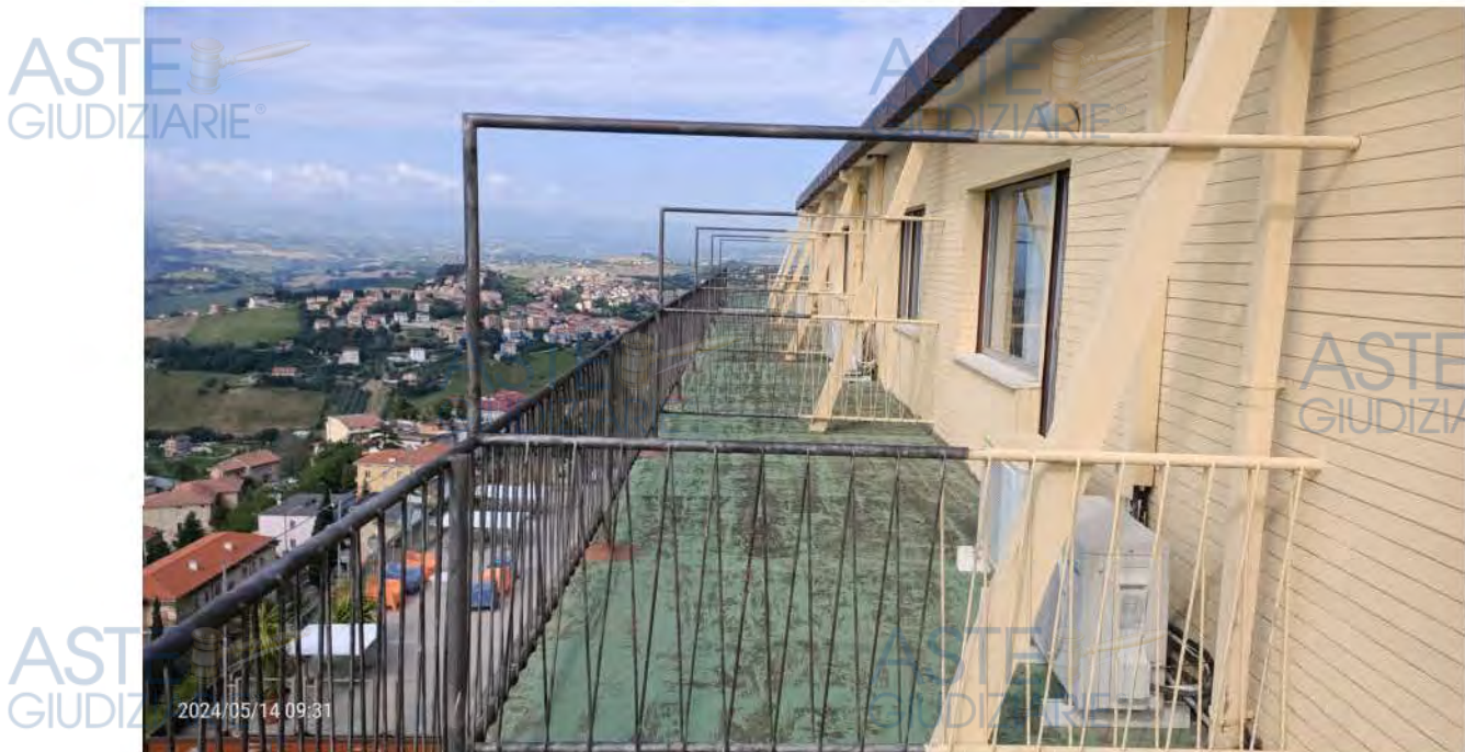
Comune di Fermo, Foglio 62 Particella 617 piano 3° vista lato Sud su terrazze delle camere
