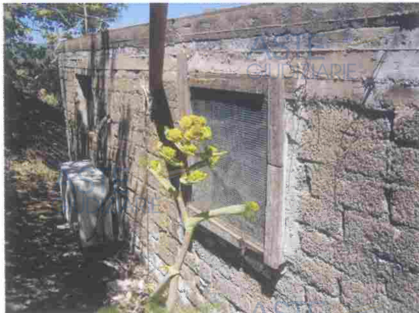
Figura 5. Vista prospetto retro magazzino
