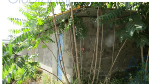
Fig. 25-28 – Tettoia Corpo A
