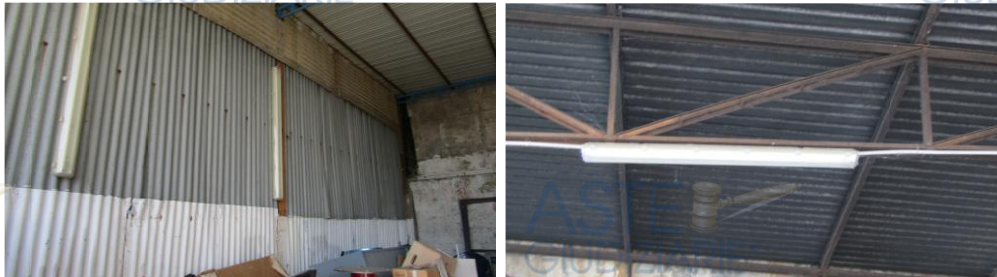
Fig. 20-24 – Tettoia Corpo A
