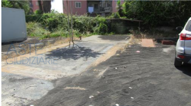
Fig. 5-11 - Condizioni del piazzale
