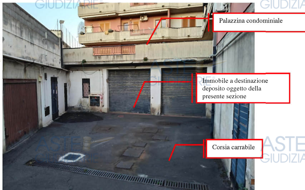
Figura 20- Visualizzazione della corsia garage e dell'ingresso all'immobile oggetto della presente sezione
