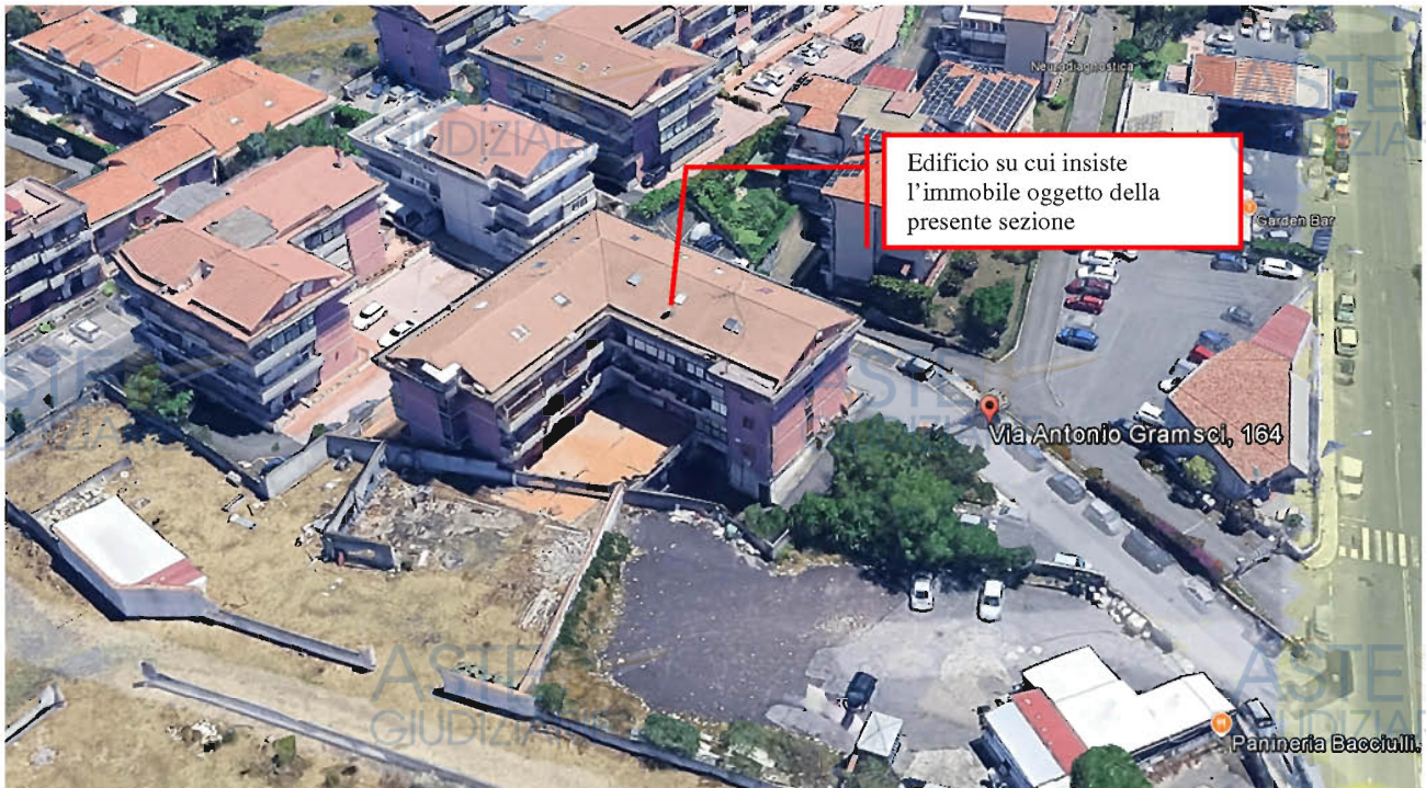
Figura 6- Visualizzazione satellitare dell'edificio su cui insiste l'immobile oggetto della presente sezione
