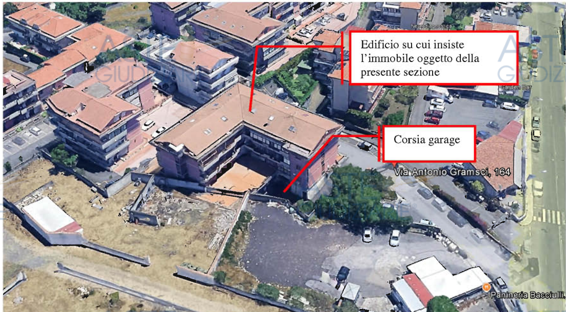
Figura 24- Visualizzazione satellitare dell'edificio su cui insiste l'immobile oggetto della presente sezione
