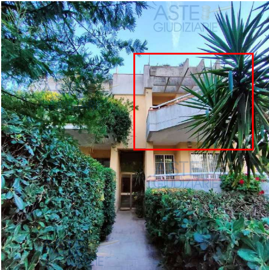
Foto3: Portoncino condominiale di accesso – Immobile P.1-2 F.gl.7 P.IIa 259 Sub.20 Tremestieri Etneo(CT)
