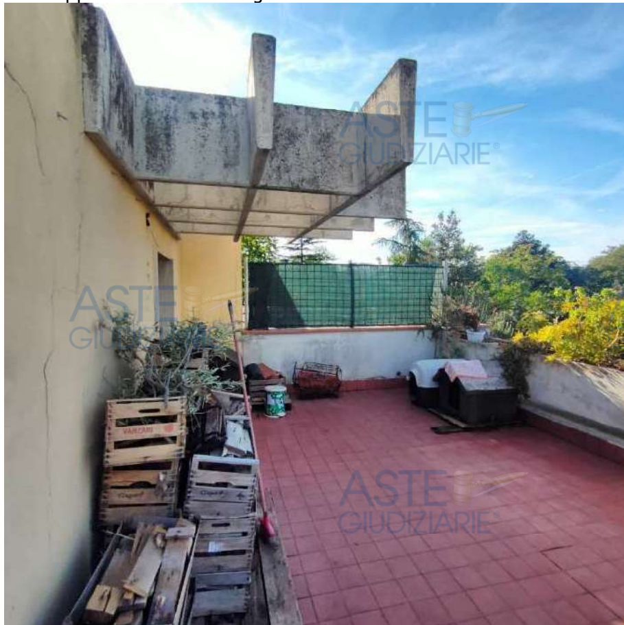
Foto26: Immobile Appartamento P.2° F.gl.7 P.Ila 259 Sub.20 – Terrazza a livello pertinenza esclusiva
