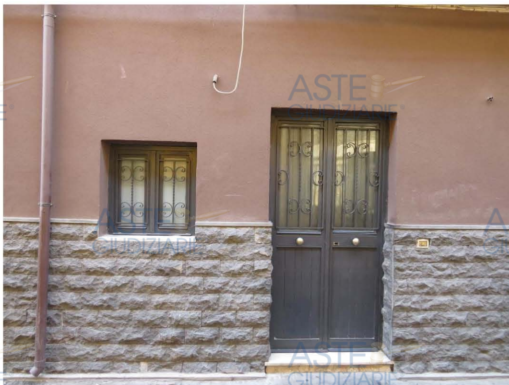
Foto 19 – Ingresso immobile via Mongiovi 20
