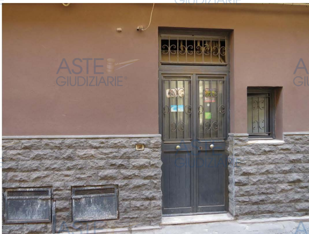
Foto 15 – Ingresso immobile via Mongiovi 18
