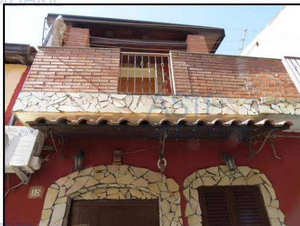
Foto 2 – Ingresso e balcone piano primo
