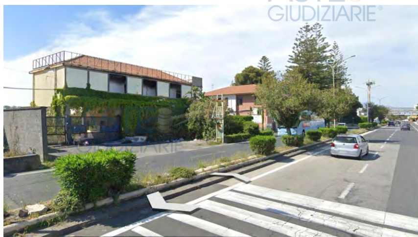
❖ Vista palazzina uffici su Via San Giuseppe alla Rena
