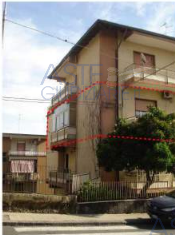
Palazzina fg. 6 mappale 782 (prospetto nord)
