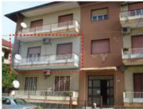
Palazzina fg. 6 mappale 782 (prospetto ovest, su C.so Sicilia)
