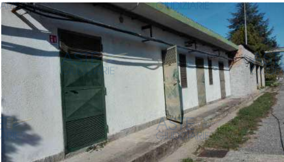
Foto 17. Porte d'ingressi dei locali corpo B
