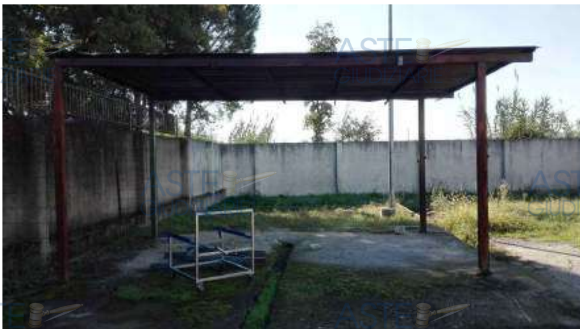
Foto 100. Tettoia corpo C.
