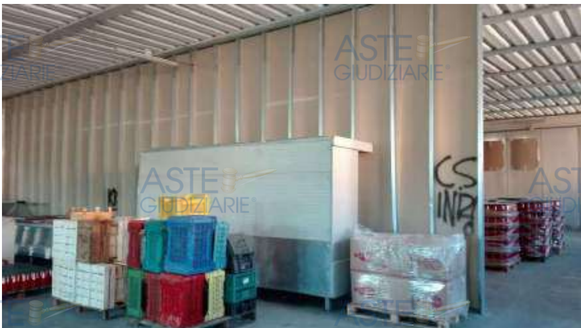
Foto 80-81. Particolari dell'interno del capannone corpo A.
