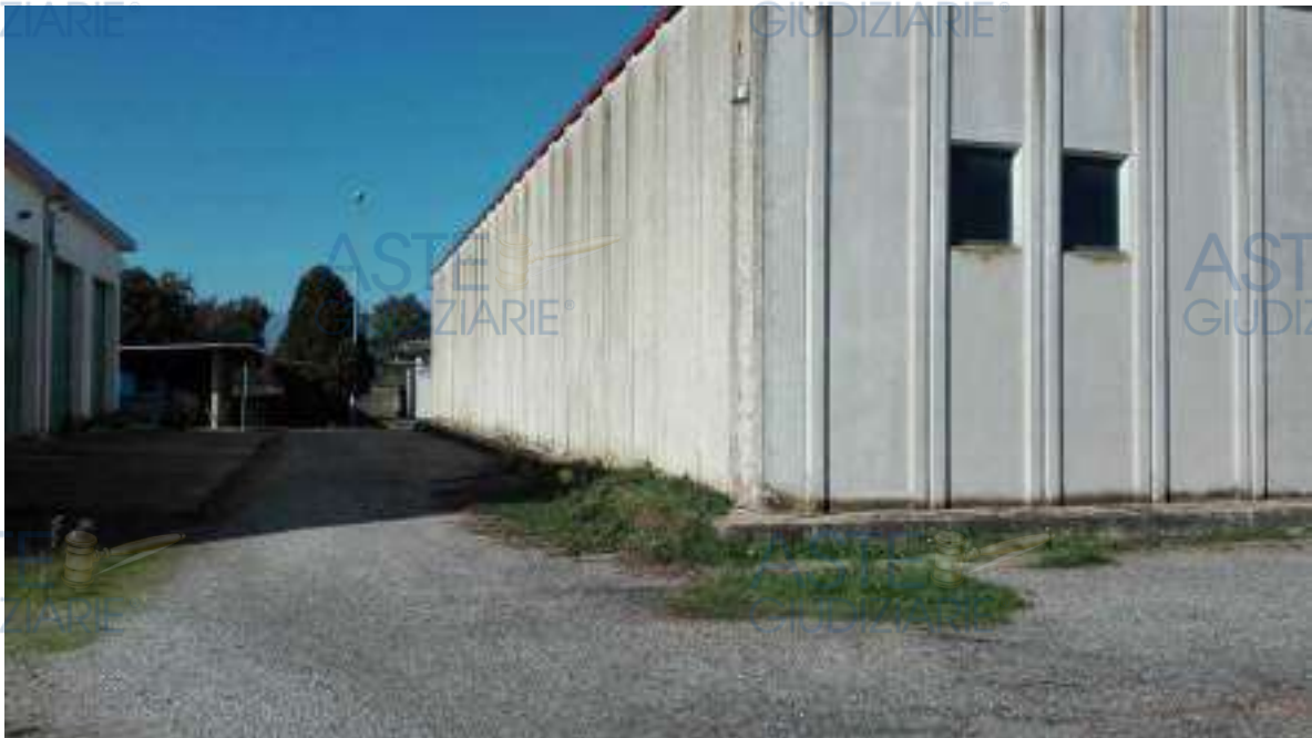
Foto 78. Facciata cieca lato sud.
