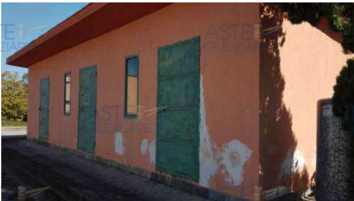
Foto 90. Facciata Corpo C.
