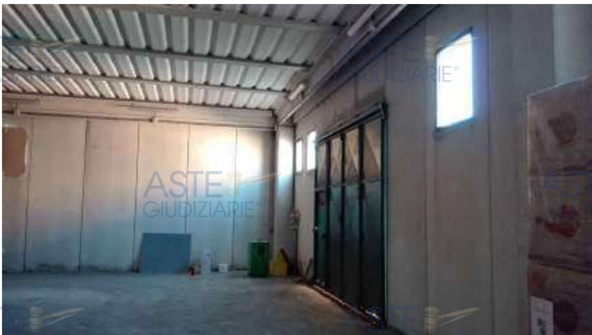
Foto 82-83. Interno del capannone.
