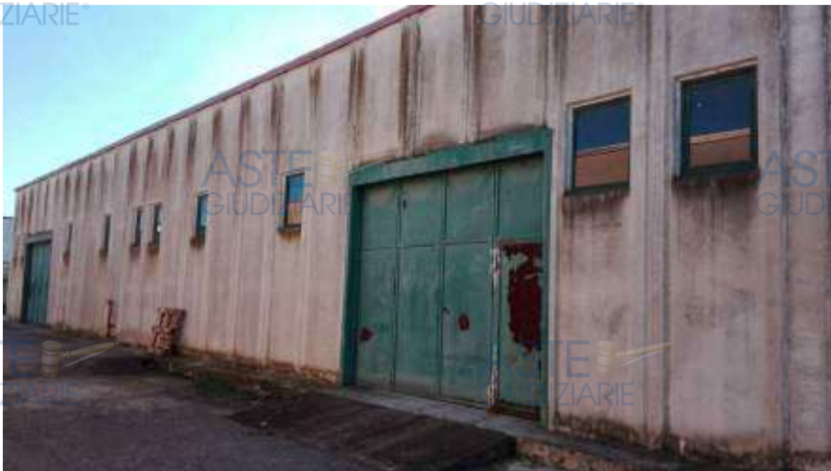
Foto 16. Porta d'ingresso scorrevole al capannone corpo A.
