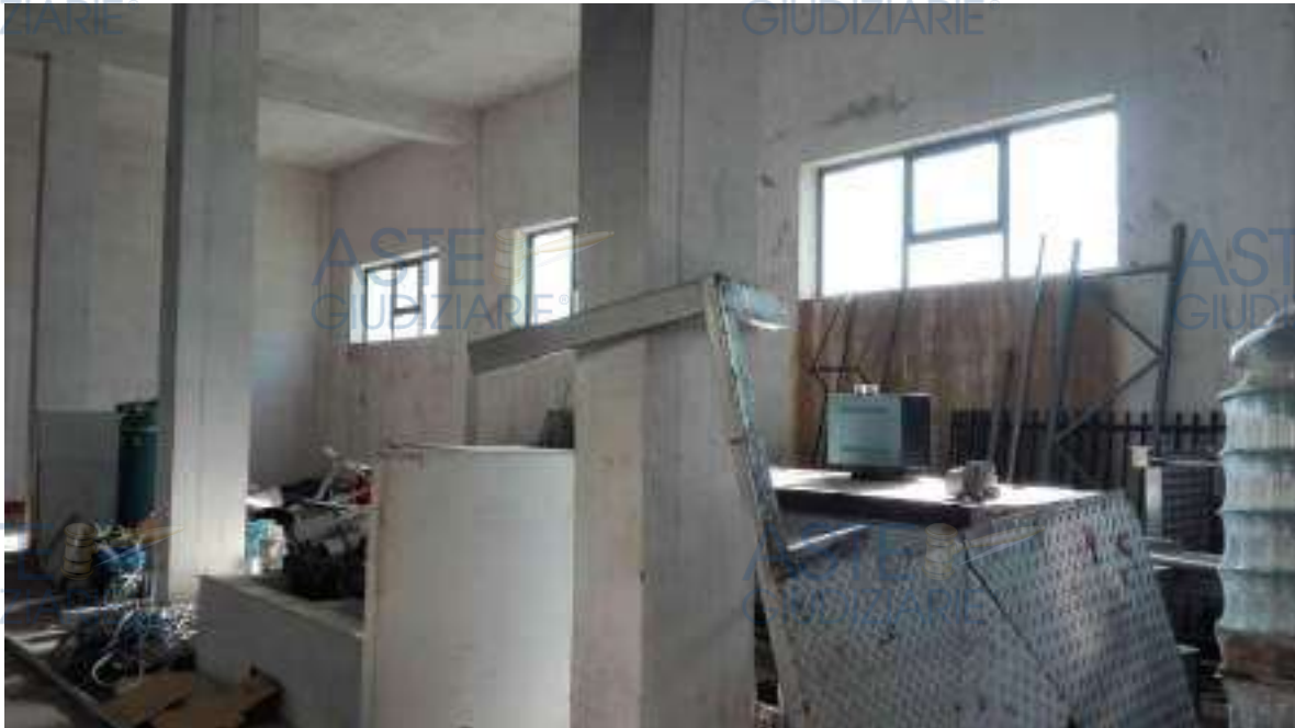
Foto 96-97. L'interno del capannone.
