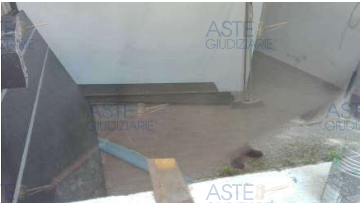
Foto 91-92. Interno del fabbricato.
