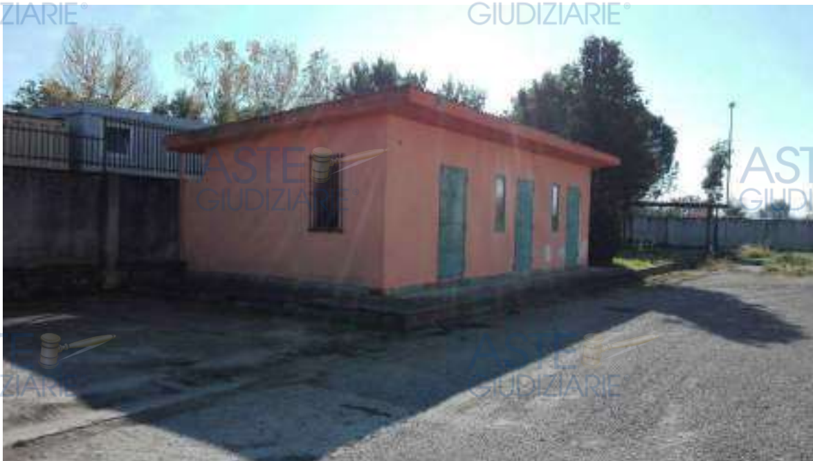
Foto 89. Fabbricato Corpo C.
