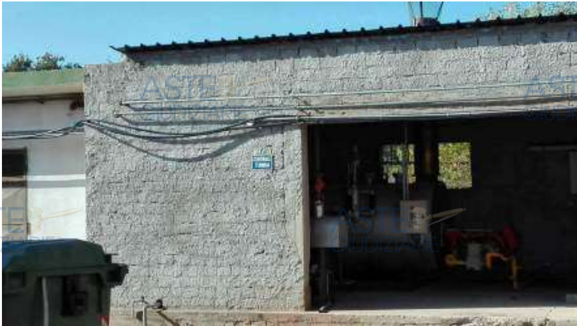
Foto 88. Costruzione non accatastata adiacente al corpo B.
