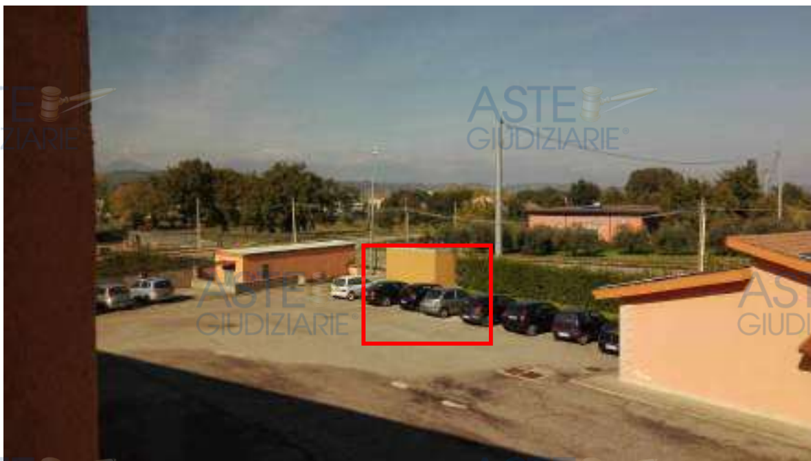
Foto 19-20. Cabina in uso all'Enel.
