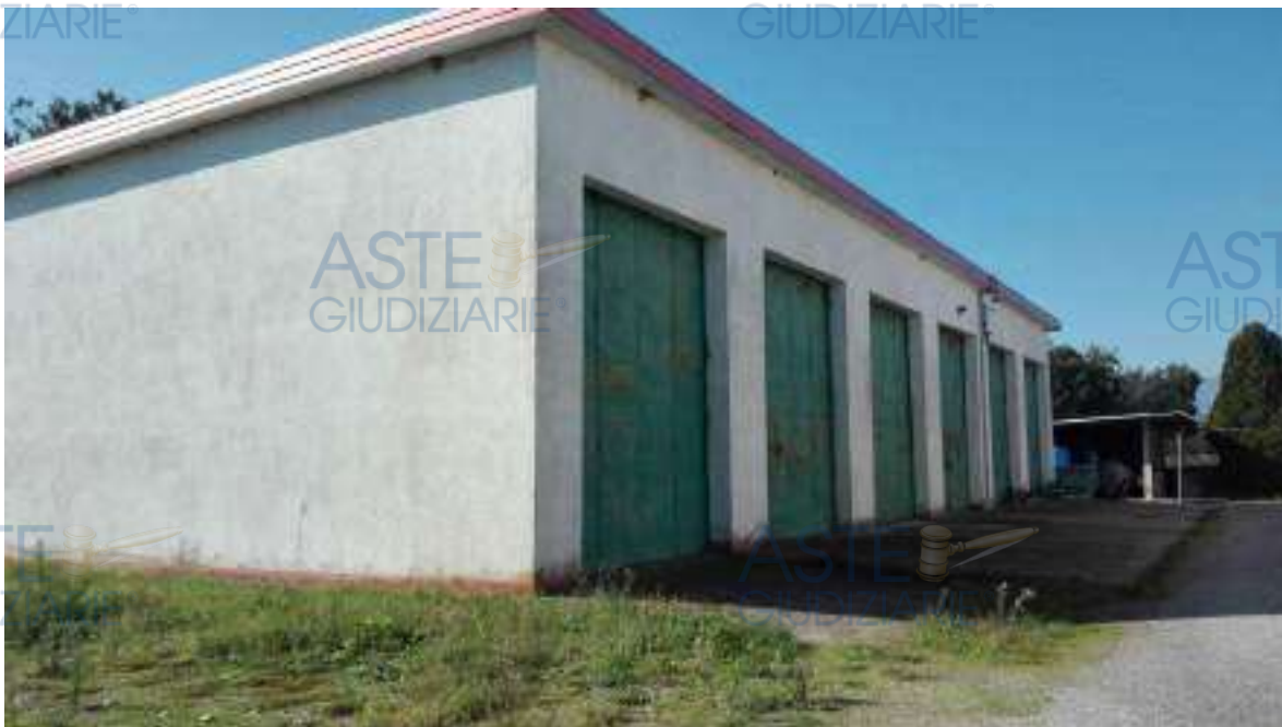
Foto 20. Il fabbricato corpo A.
