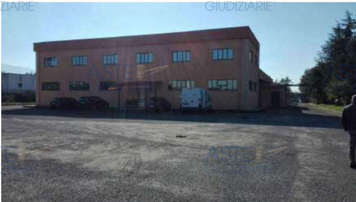
Foto 22. Prospetto lato nord.
