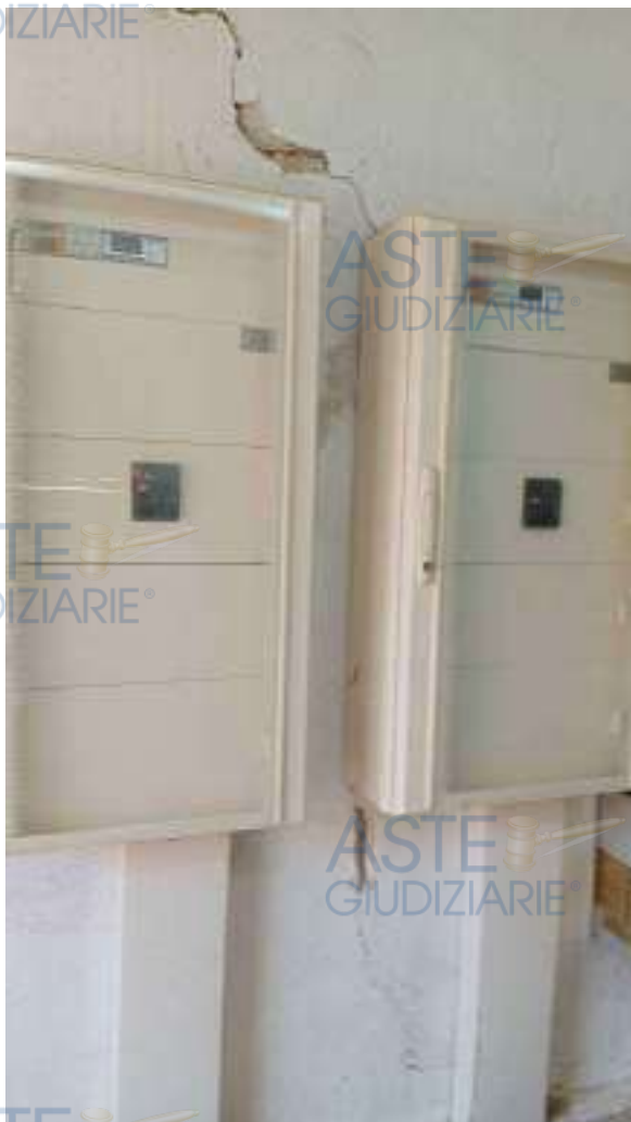
Foto 5-6-7. Particolari della lesione sul locale cabina Corpo B
