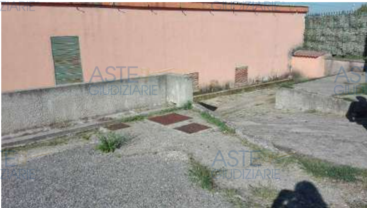
Foto 12-13. Facciata lato est immobile Corpo B
