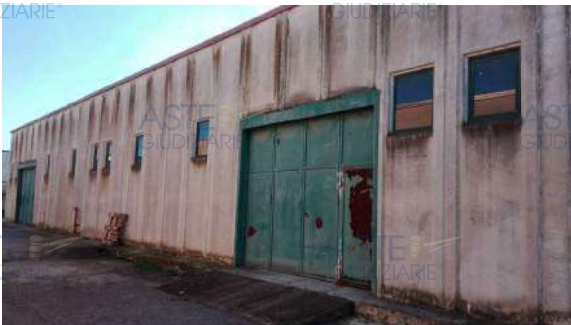
Foto 74. Porta d'ingresso scorrevole al capannone corpo A.
