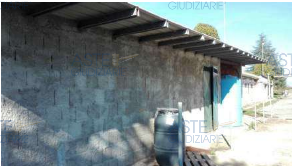
Foto 98. Facciata corpo B.
