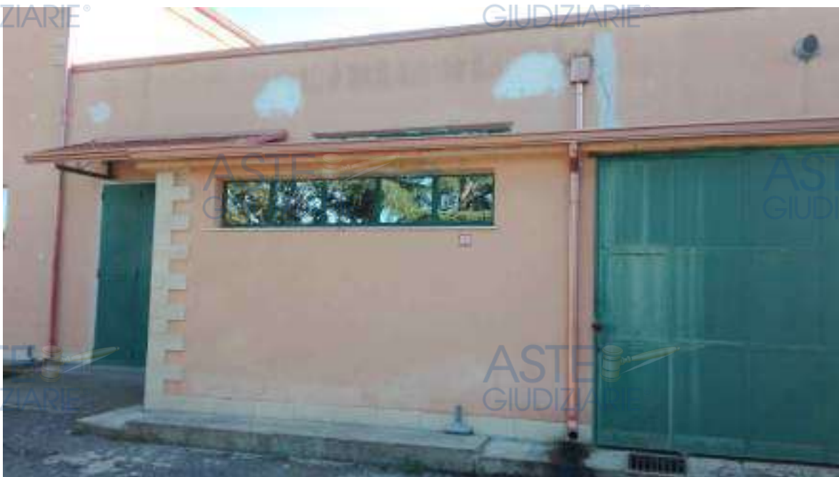
Foto 64. Corpo B lato ovest.
