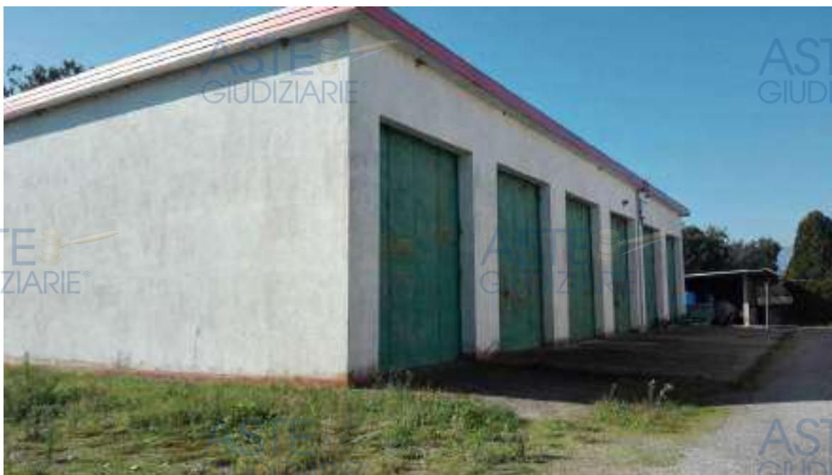
Foto 94. Il fabbricato lato nord est.
