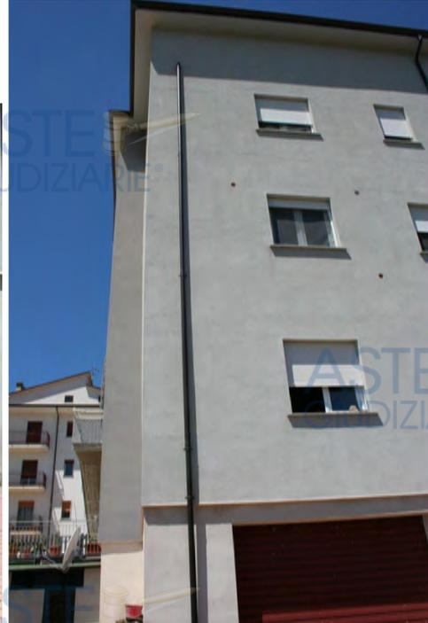
L'edificio è realizzato con struttura a travi e pilastri in cemento armato e tamponamenti laterali in laterizio intonacati. L'edificio si sviluppa su 5 livelli, di cui uno seminterrato e 4 fuori terra.
