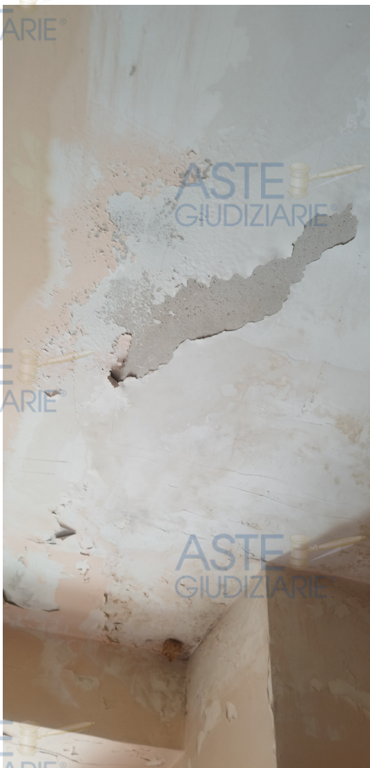
Foto n°8: – Particolare del soffitto del bagno dell'appartamento posto al piano 1° sottostante l'u.i. oggetto di esecuzione dove è presente lo scrostamento della tinteggiatura; la zona, al tatto è risultata completamente asciutta.
