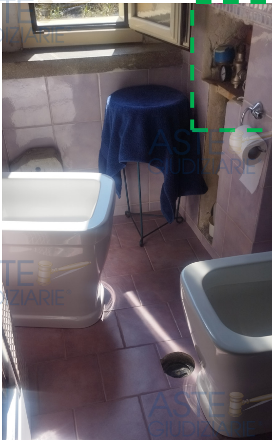
Foto n°4: –App. Bagno 1 zona WC;
