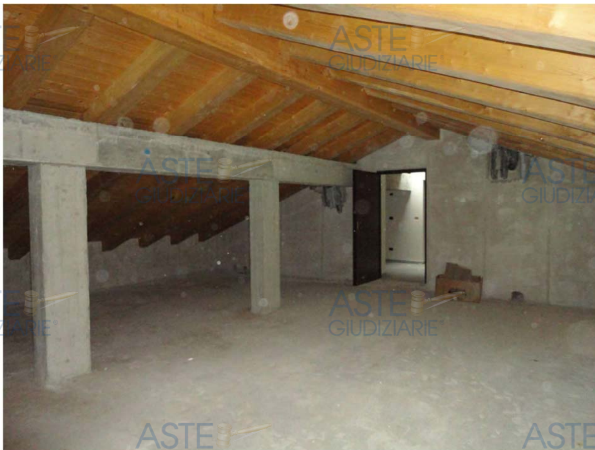
Residenza Argentera – interno sottotetto
