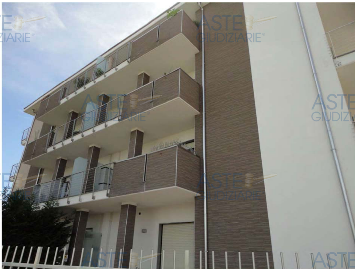
Residenza Belvedere - esterno
