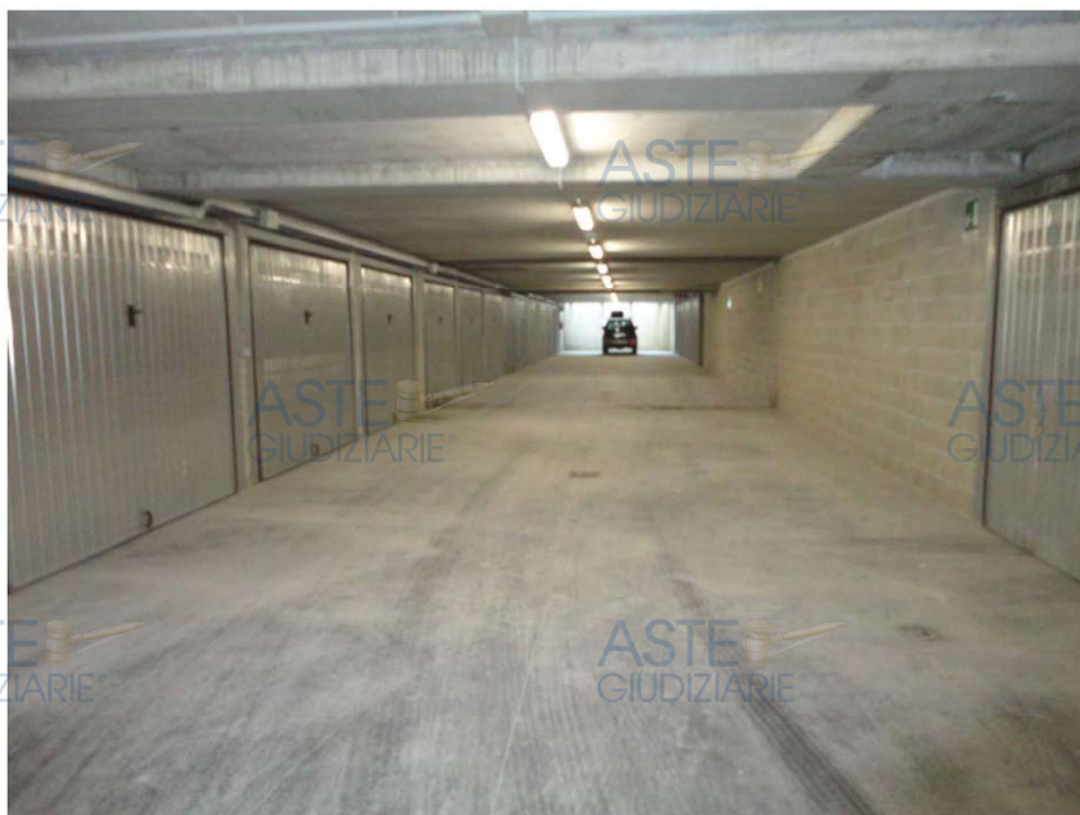
Residenza Maneggio - Autorimesse
