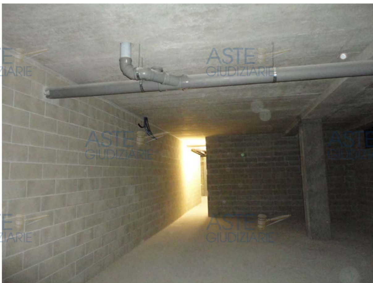
Residenza Belvedere – interno magazzino
