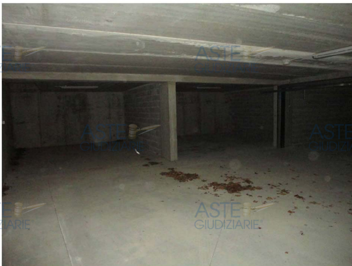
Residenza Argentera – Autorimessa
