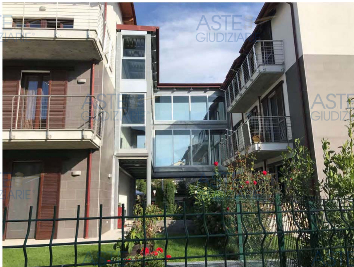
Residenza Maneggio - esterno
