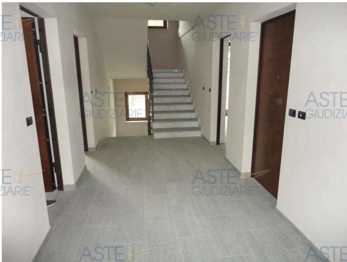
Residenza Argentera – vano scala
