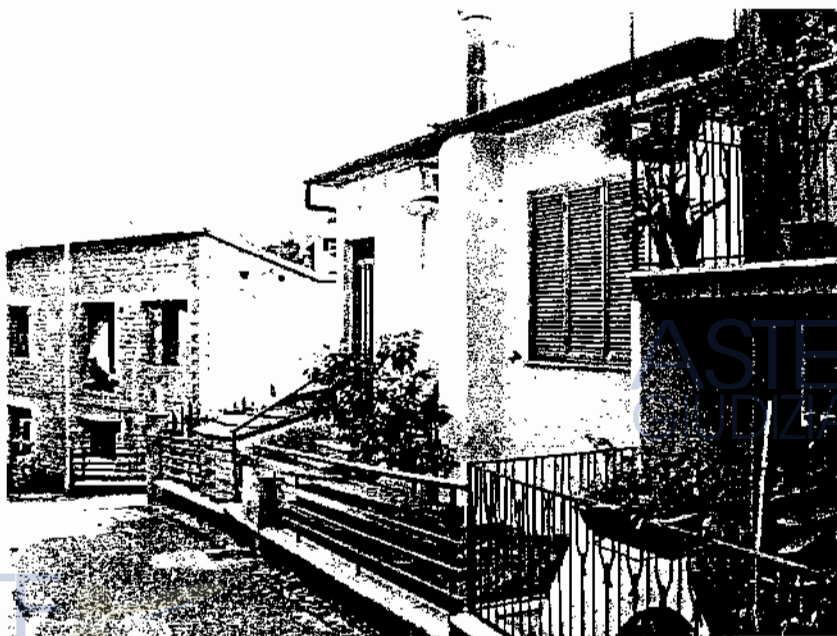
Fig. (2) - Ingresso abitazione “lato Ovest” (Piano Primo)
