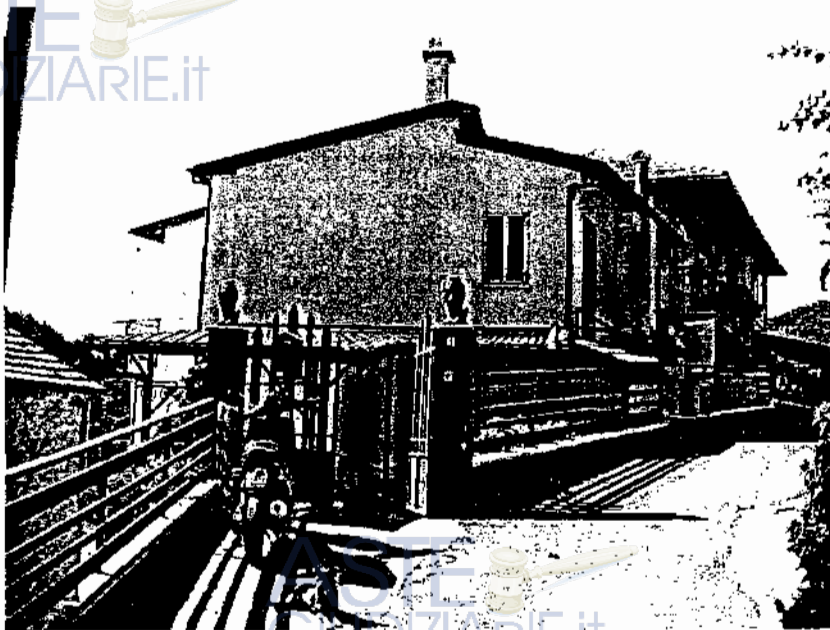
Fig. (1) - Ingresso abitazione “lato Nord” (Piano Terra)
