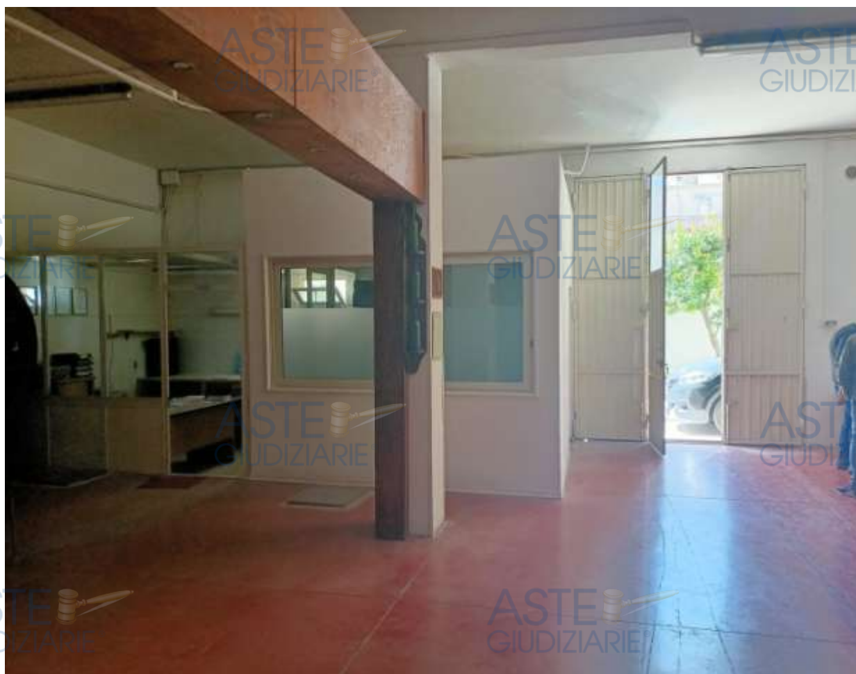
Secondo vano con vista sull'apertura metallica e sui due vani adibiti a ufficio
