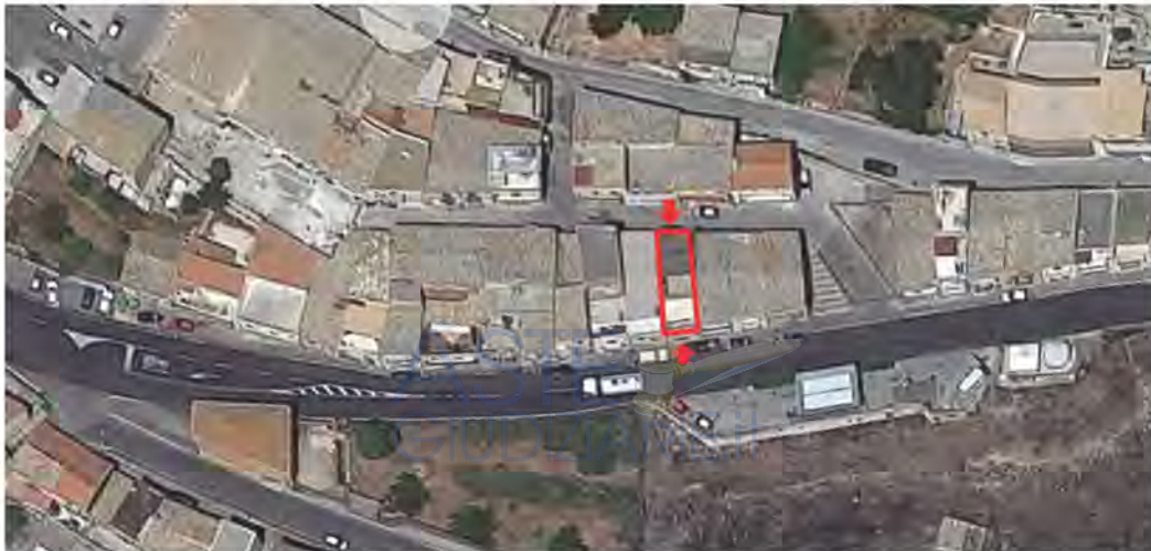
Immagine 1: Inquadramento urbano del fabbricato indicato con il contorno in rosso. Le frecce indicano gli accessi alle due diverse quote: da Via Galli al civico n.175 e da Via M. Bianchi al civico n.46.
