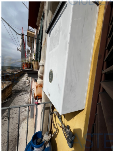
Figura 8 – Ballatoio lato sud-ovest
