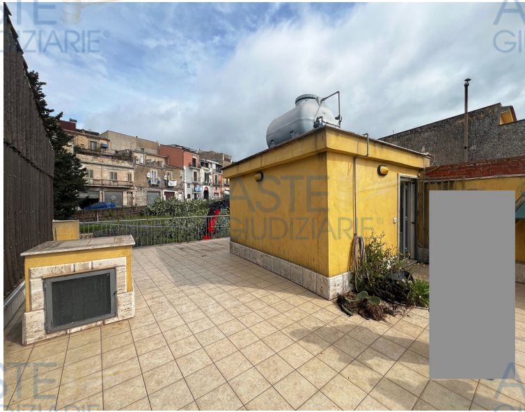
Figura 3 – terrazza al piano secondo
