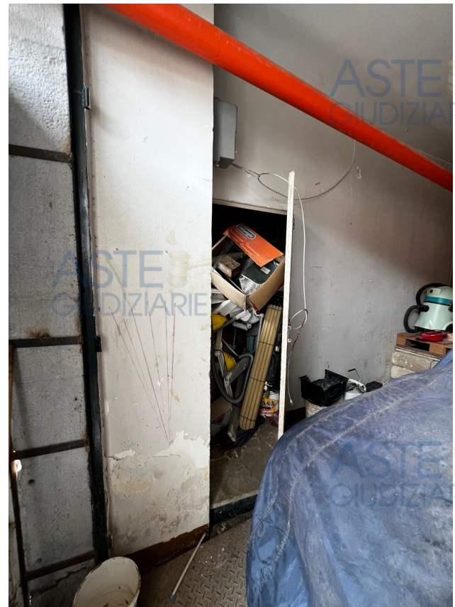
Figura 17 – Vano cantinato antistante
