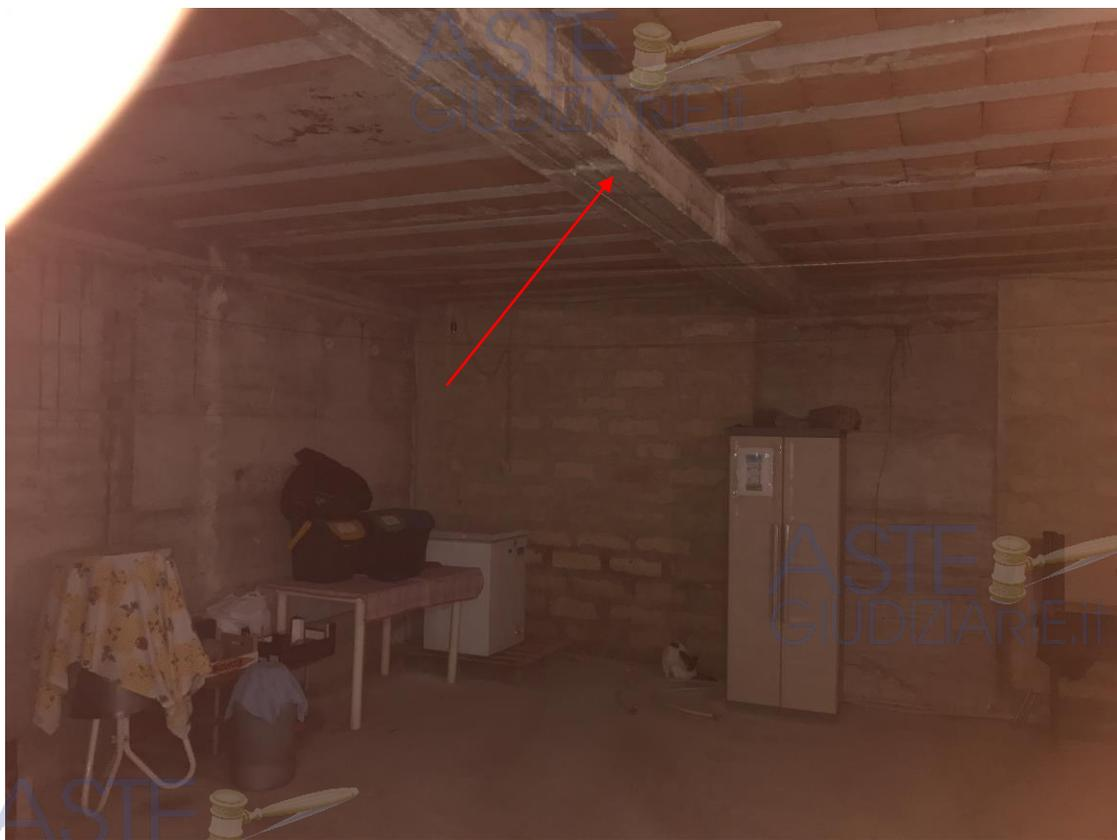
*Foto interno garage con in alto la trave corrispondente alla tramezzatura abbattuta abusivamente*
