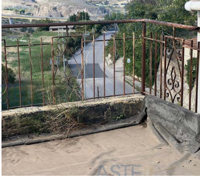
Figura 8 – particolare della guaina sul lastrico solare
