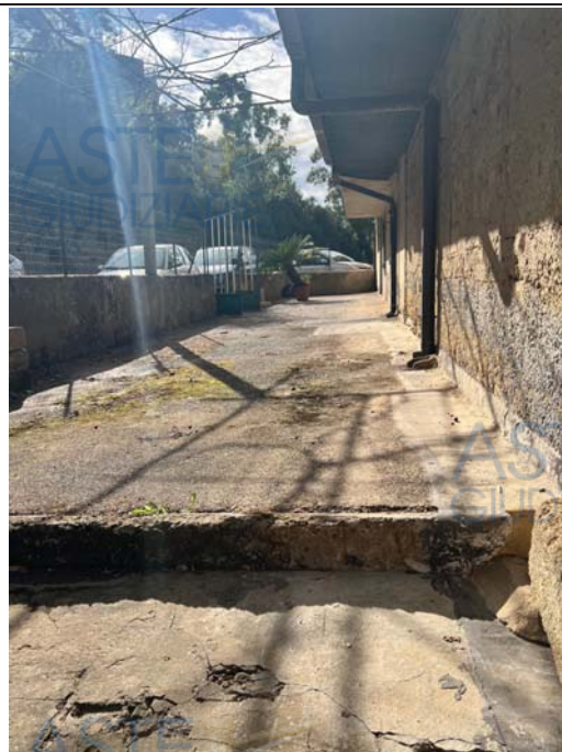
Figura 6 – Particolare del prospetto sulla via Pantalica parzialmente al di sotto del piao stradale
