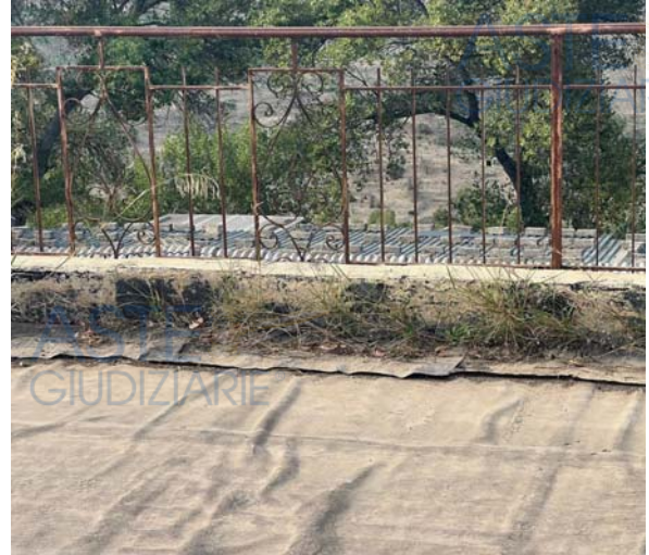
Figura 9 – particolare della guaina sul lastrico solare
