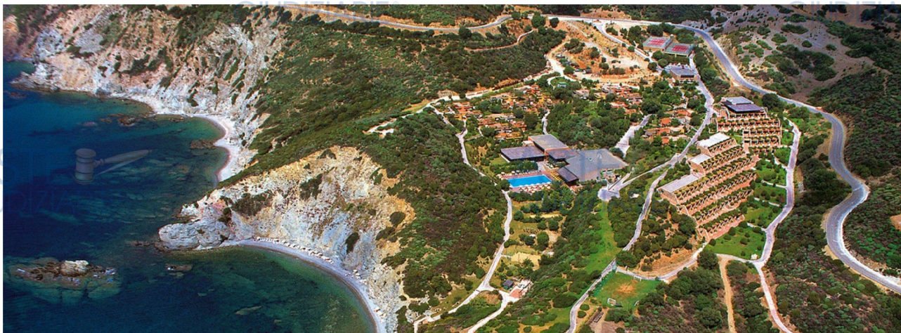
Fig. 2 – foto storica del complesso alberghiero precedente la demolizione.
