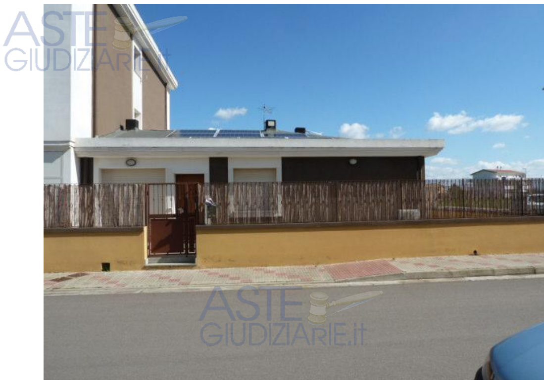
Foto n. 17 prospetto principale (riportata nell'allegato fotografico)
