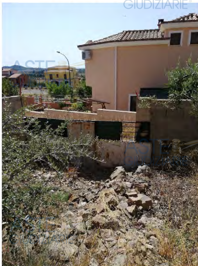
Foto 21) Cortile privo ancora di rifiniture, lato stradello su confine Est.
