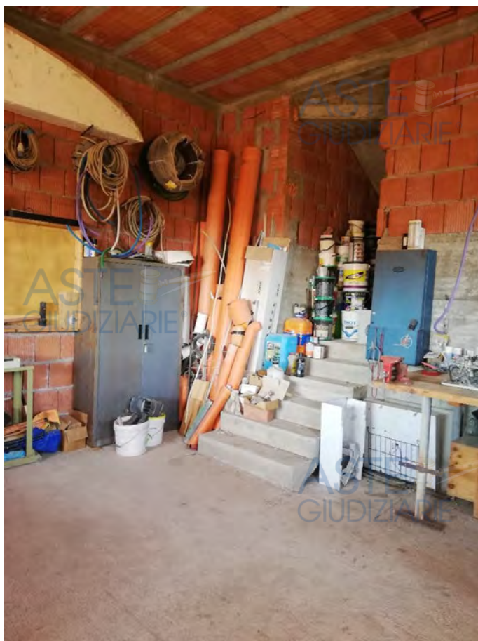
Foto 20) Interno locale seminterrato privo di rifiniture.
