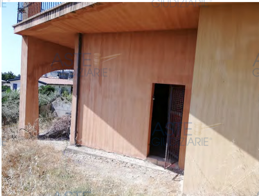
Foto 19) Ingresso dal cortile al locale seminterrato privo di rifiniture.
