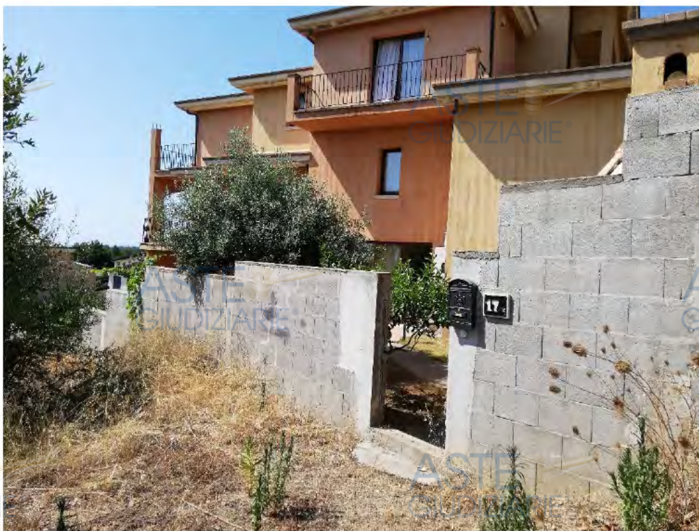
Foto 2) Ingresso pedonale lato area verde pubblico, verso il cortile interno quota piano seminterrato.
