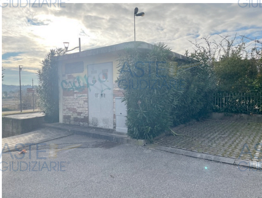
LOTTO 9 – part. 11018 – cabina elettrica
