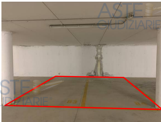
Figura 06: Posti auto coperti sub. 83-84
