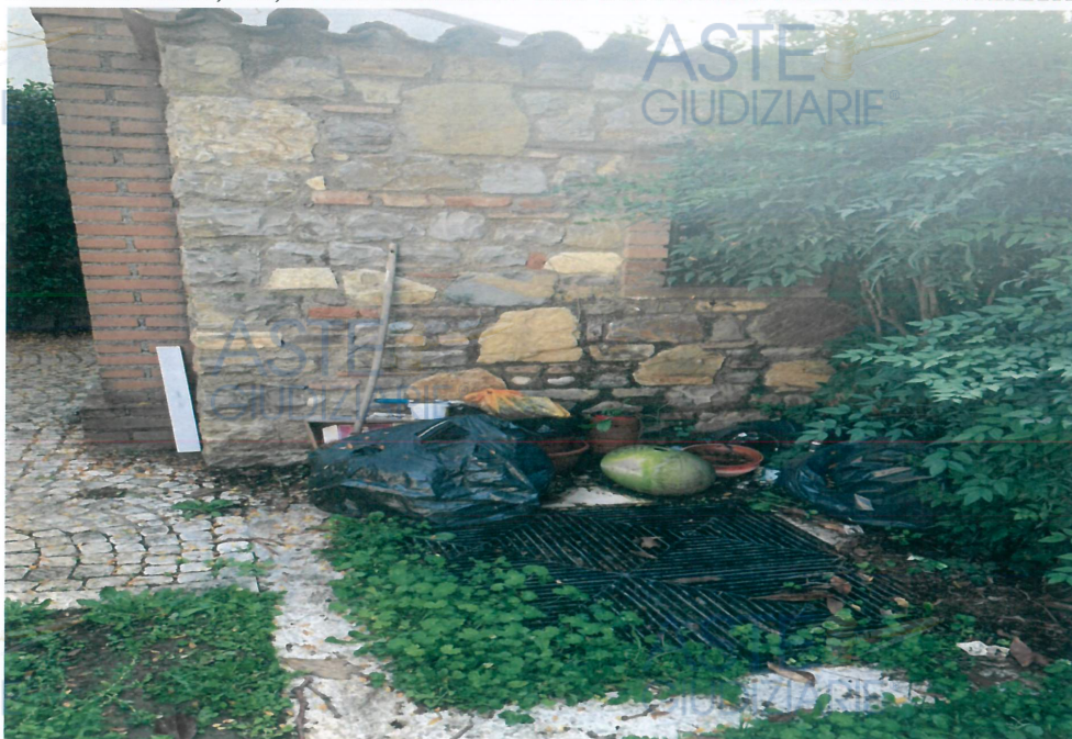
CADITOIA dim. 1,00x1,00 NEL GIARDINO: CHE DANNEGGIA ZONA NELL'INTERRATO
