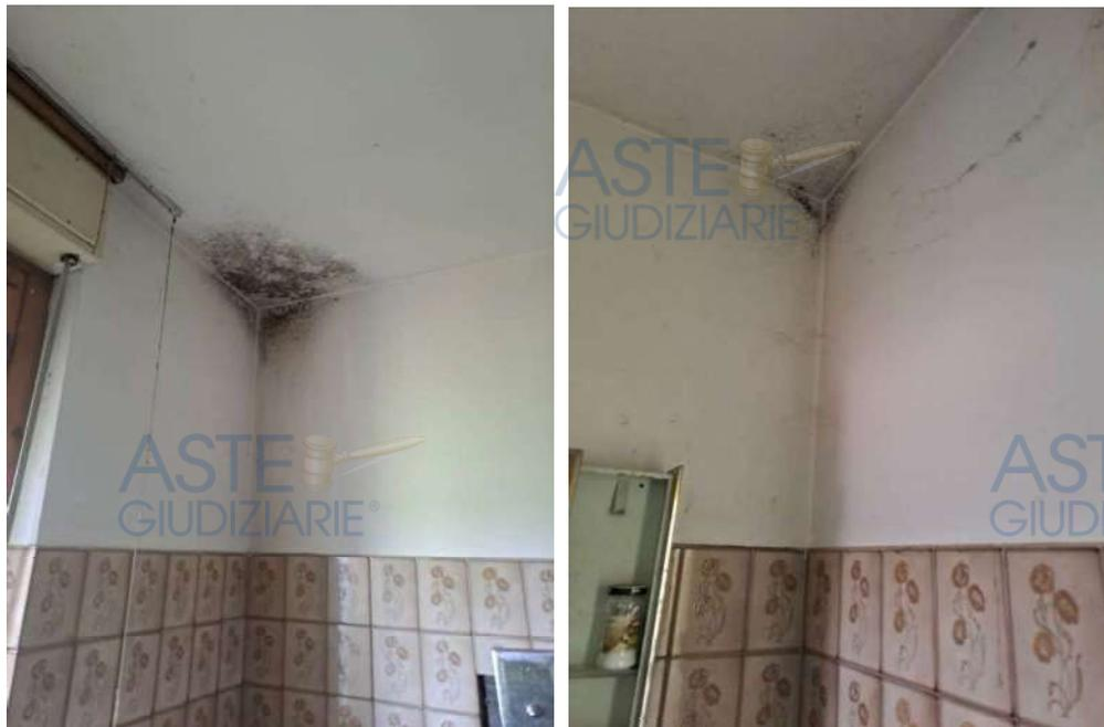
Nelle immagini è possibile visualizzare la presenza di muffa posta sulle pareti e solaio del bagno al piano secondo
