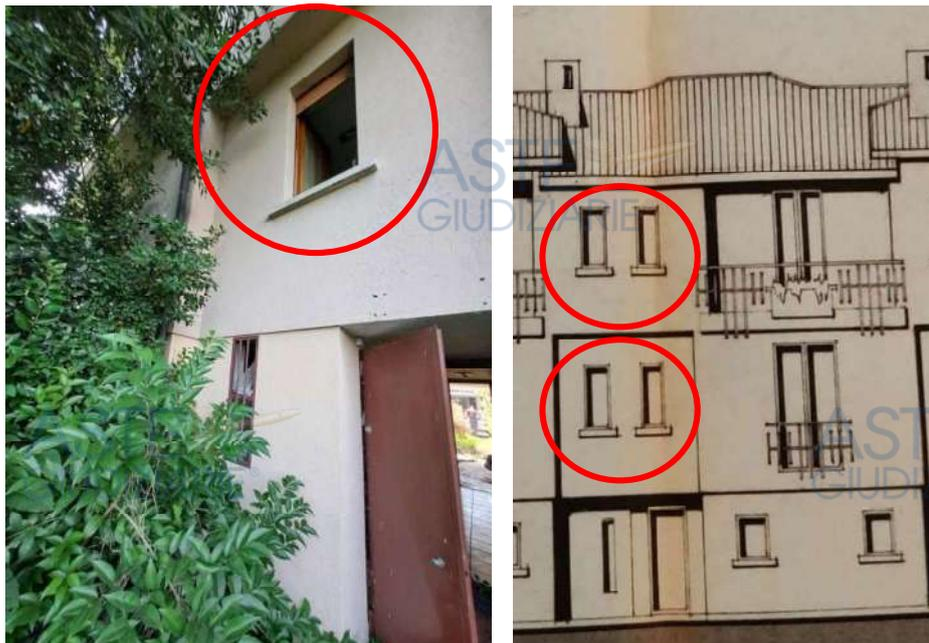
*Nell'immagine di destra è possibile visualizzare la presenza di una sola finestra presente all'interno del bagno anziché due come invece indicato nelle tavole di progetto. Nell'immagine di sinistra è possibile*
