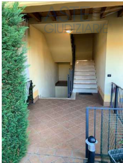
Fig. 05: Vano scala condominiale
