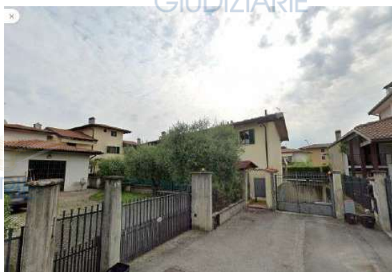
Fig. 07: Accesso pedonale secondario e accesso carraio da via Calca n. 12
