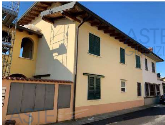
Fig. 04: Vista prospetto nord da via San Vincenzo
