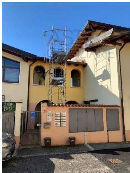
Fig. 03: Accesso pedonale principale da via San Vincenzo n. 30
