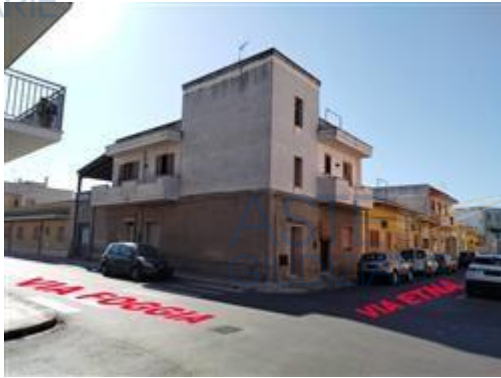
1 - VISTA DELL'EDIFICIO DA VIA FOGGIA
