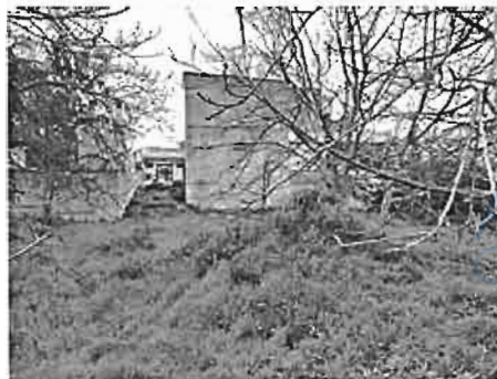
Particolare vista terreno
