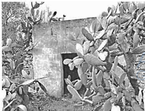
Vista accesso fabbricato in stato di abbandono
