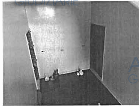
Accesso all'immobile dal vano scala - piano primo
