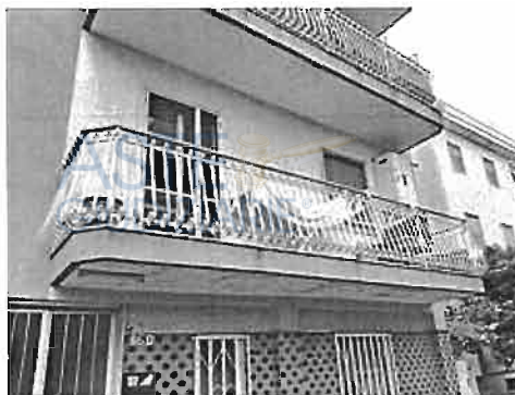
Vista immobile al piano primo
