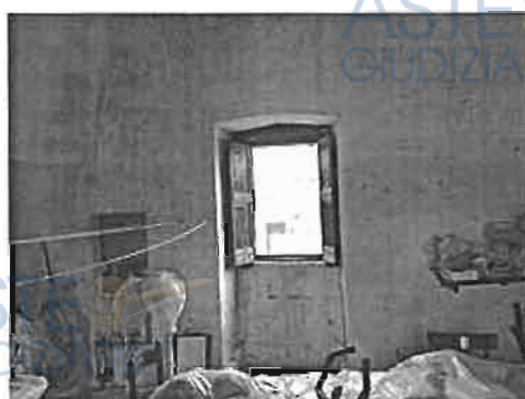
Particolare vista interna, locale Piano primo
