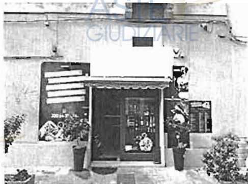
Vista ingresso attività commerciale da Via Spinelli T. Attilio
