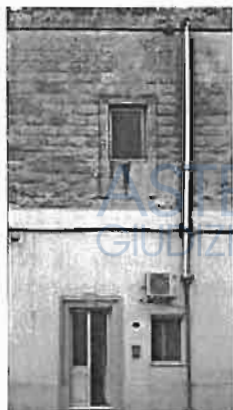
Vista prospetto immobile da Via San Pancrazio
