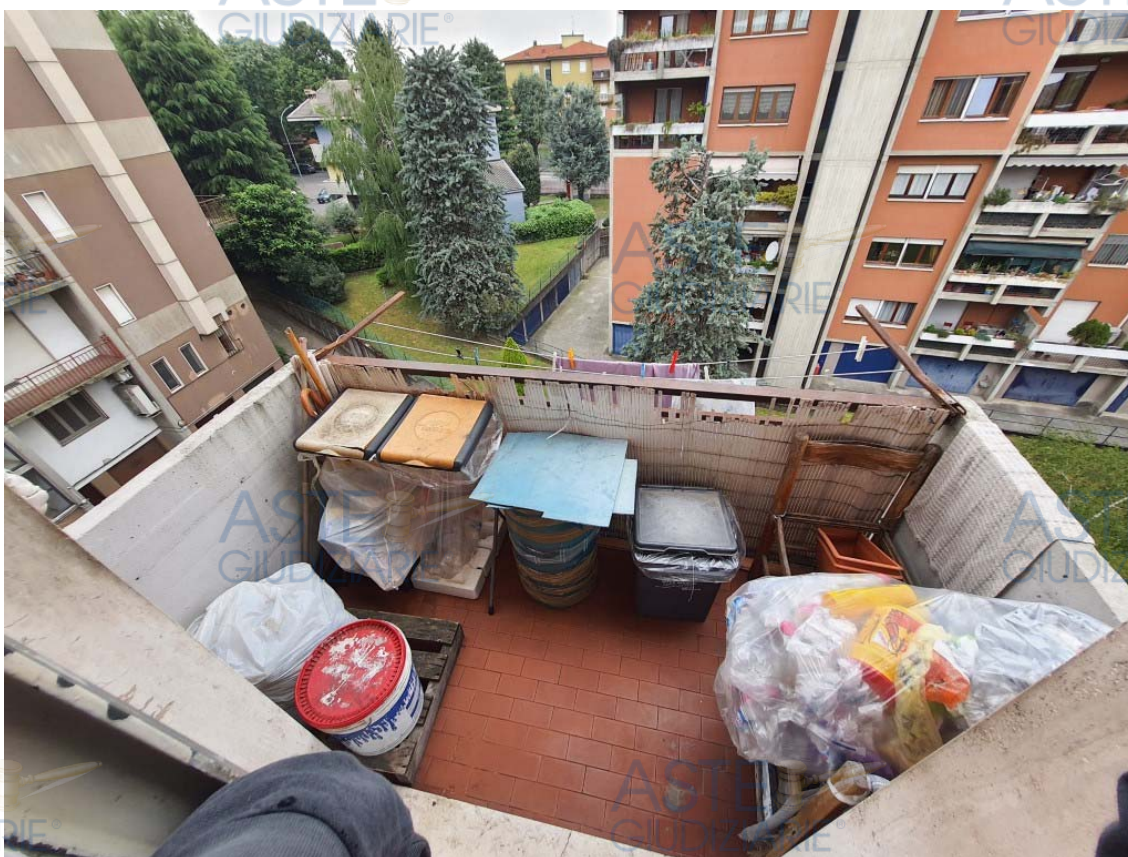
RILIEVO INTERNO – Foto 19 e 20. Riprese dei balconi dei locali Soggiorno-Pranzo e Cucina.
