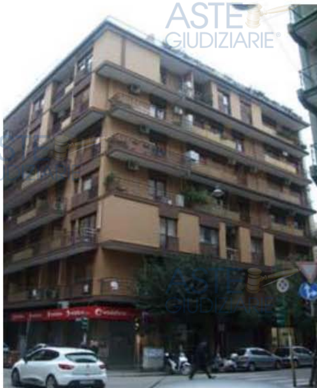
Foto 1: Palazzo di sei piani , destinati ad appartamenti e piano terra a negozi, tra via De Rossi e Via Calefati – Appartamento oggetto di stima è posto al 2° piano.
