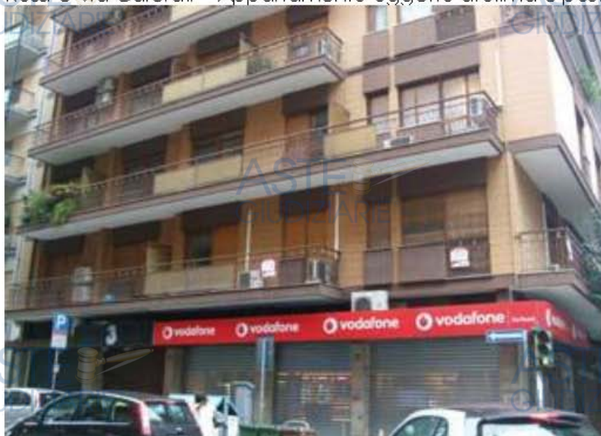
Foto 2: Prospetto su Via Calefati, appartamento oggetto di stima posto al 2° Piano.
