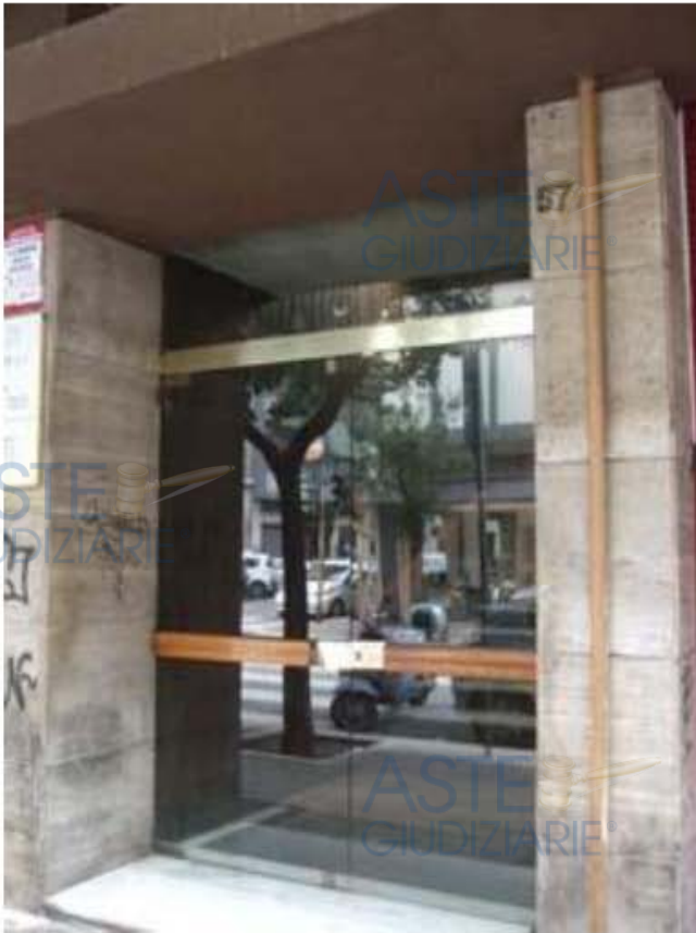
Foto 3: Portone d'ingresso su via De Rossi n°57.
