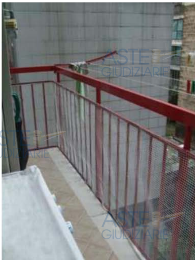
Foto 19: Balcone che si affaccia sull'atrio interno, dove è posta la caldaia a gas metano, i balconi hanno tutti ringhiere in ferro, con pavimentazione in gres ceramico.
