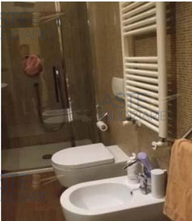
Foto 10: Bagno completo, con Box doccia, con lavabo su mensola, bidè e wc e termo arredo, con scarico a parete tipo "Geberit". Con rivestimento in marmo del tipo a "mosaico" di buona qualità.
