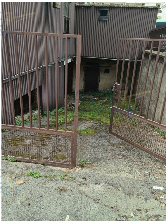
Rampa carrabile P.LLA N. 1387 - Foto n. 3
