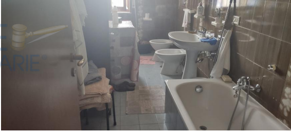
Particolare W.C. - Foto n. 15
