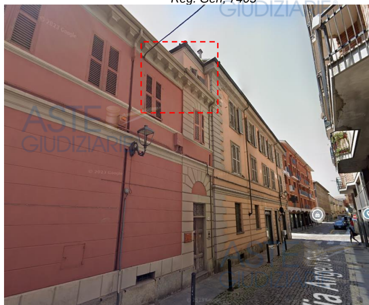
Foto 2: Nell'immagine si vede il volume di proprietà di terzi edificato sopra il tetto dell'unità oggetto di procedura
