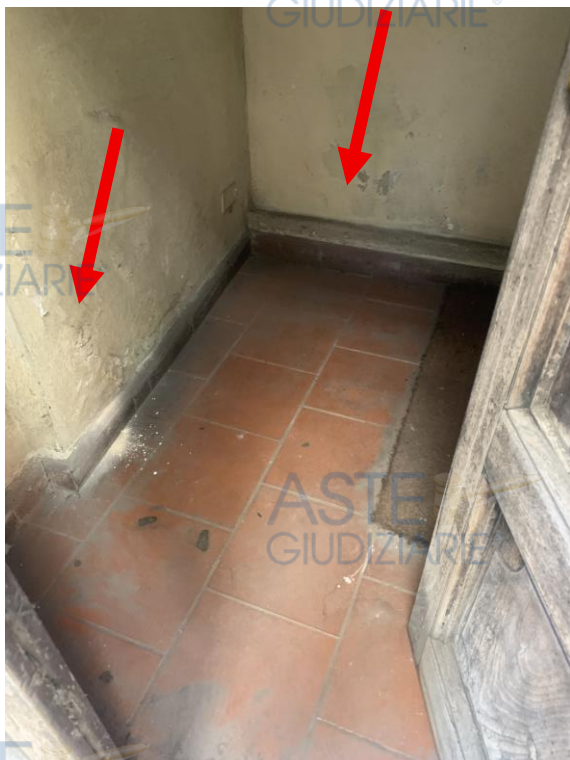
Foto 11-12: L'interno del disimpegno, efflorescenze su parete e condizioni pavimentazione
