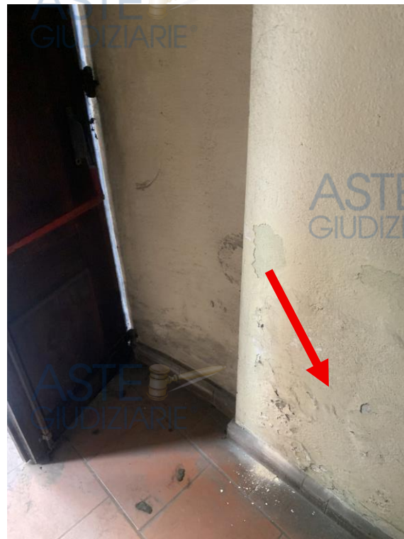
Foto 9-10: L'interno del disimpegno, vista su esterno ed efflorescenze su parete
