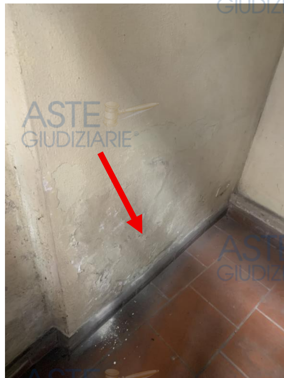
Foto 11-12: L'interno del disimpegno, efflorescenze su parete e condizioni pavimentazione
