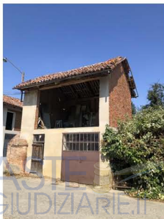
Fronte EST - Vista dalla strada comunale
