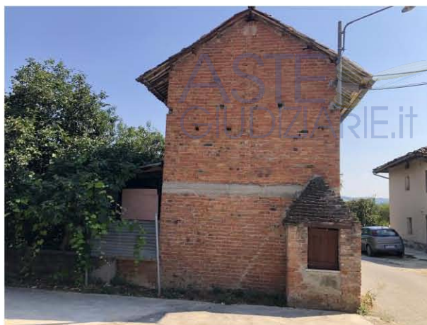
Fronte NORD - Vista dal cortile privato di altra ditta fg 16 particella 750
