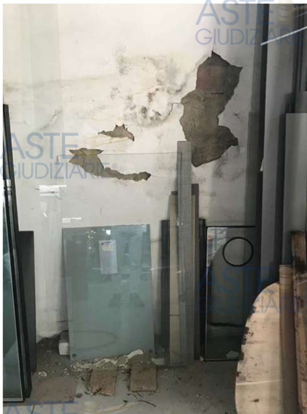
Foto 1 (Vista parete interna capannone)
