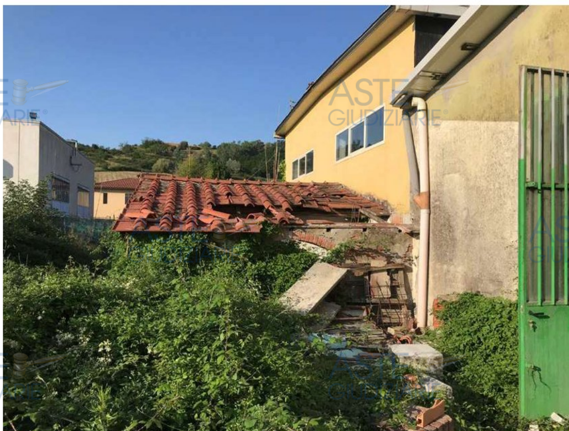
Foto 2 (Vista esterna manufatto e vegetazione)
