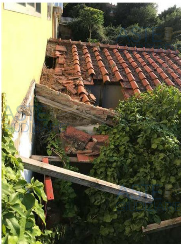
Foto 4 (Vista esterna manufatto e vegetazione)
