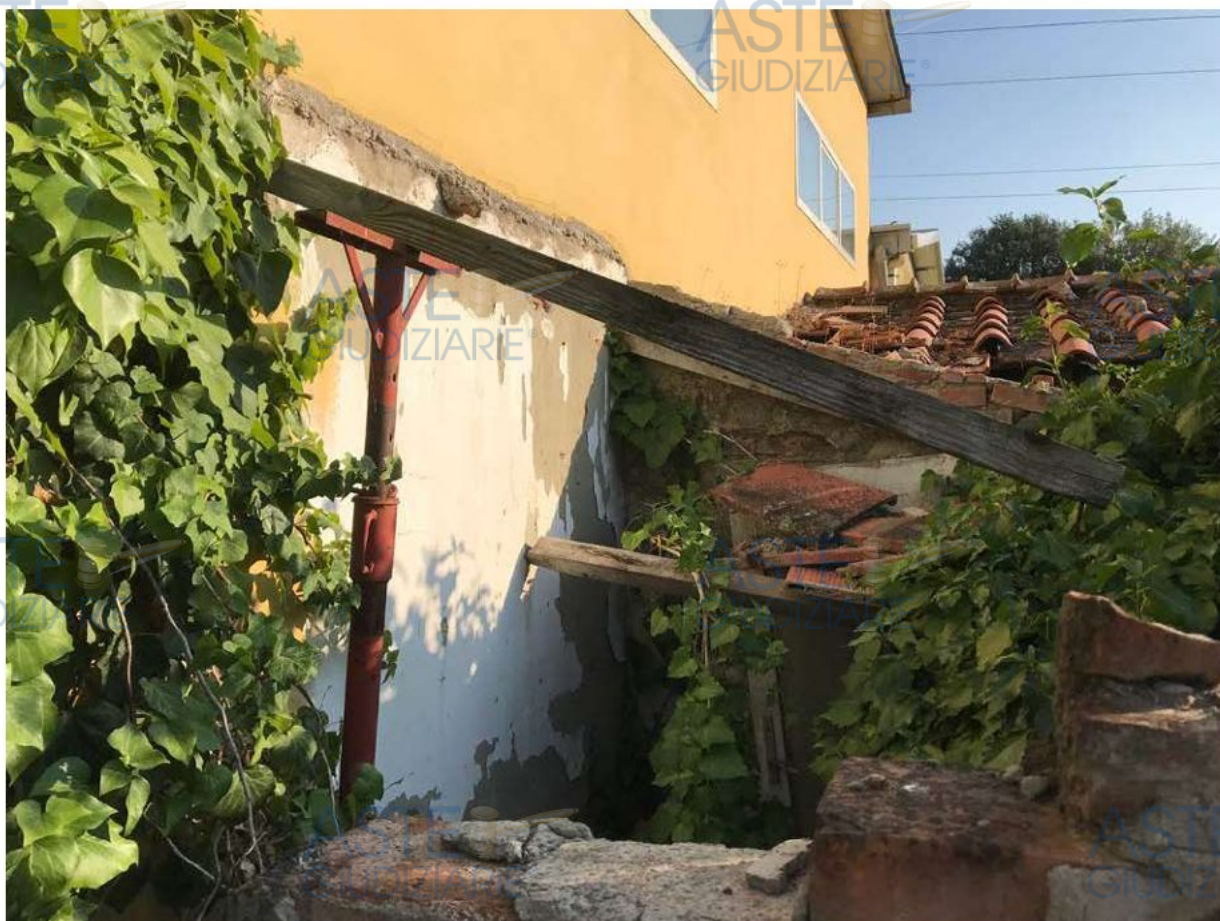
Foto 3 (Vista esterna manufatto e vegetazione)
