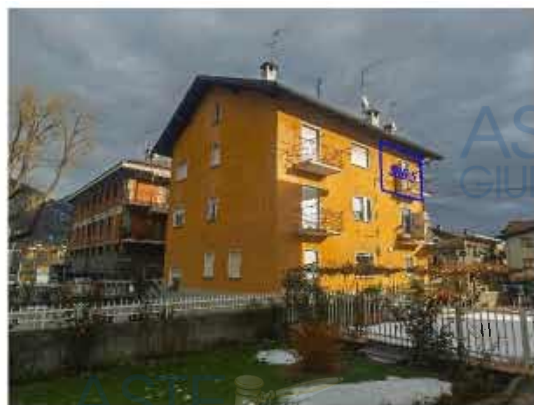
Foto 2 - Vista sud-ovest edificio
