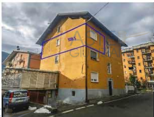
Foto 1 - Vista nord-est edificio
