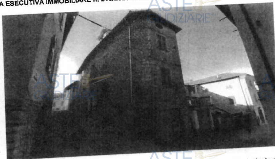
Vista principale del fabbricato
