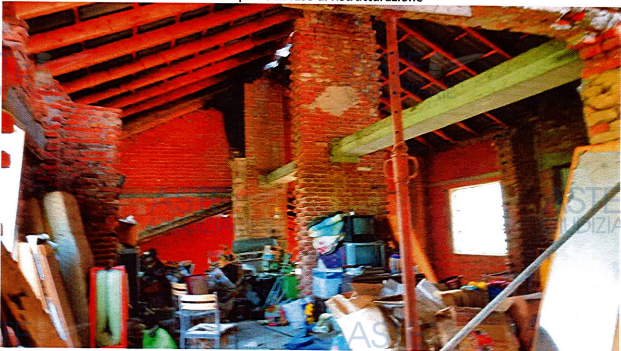
Primo piano in fase di ristrutturazione
