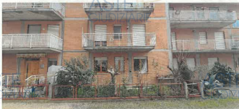
Immagine 16 Vista esterna sul retro dal resede comune
