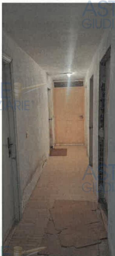
Immagine 18 Corridoio condominiale: accesso cantina e garage
