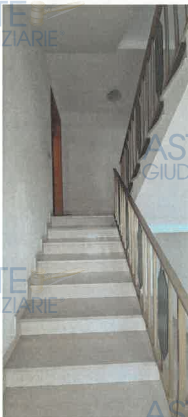
Immagine 17 Vano scala condominiale
