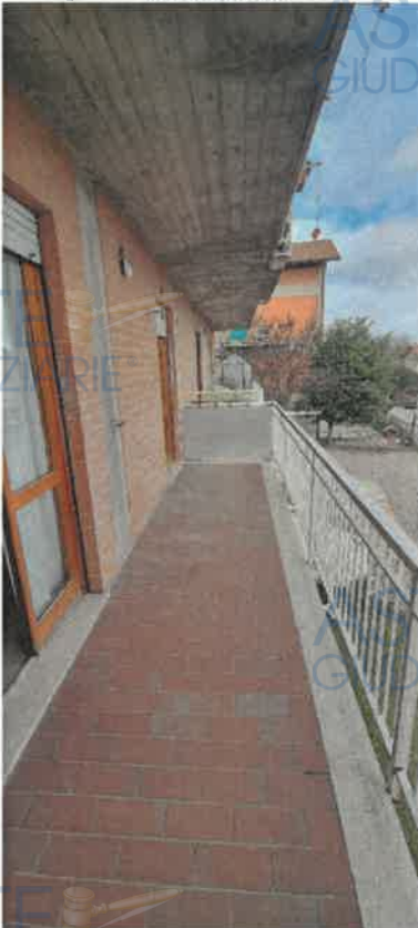
Immagine 10 Terrazza fronte strada
