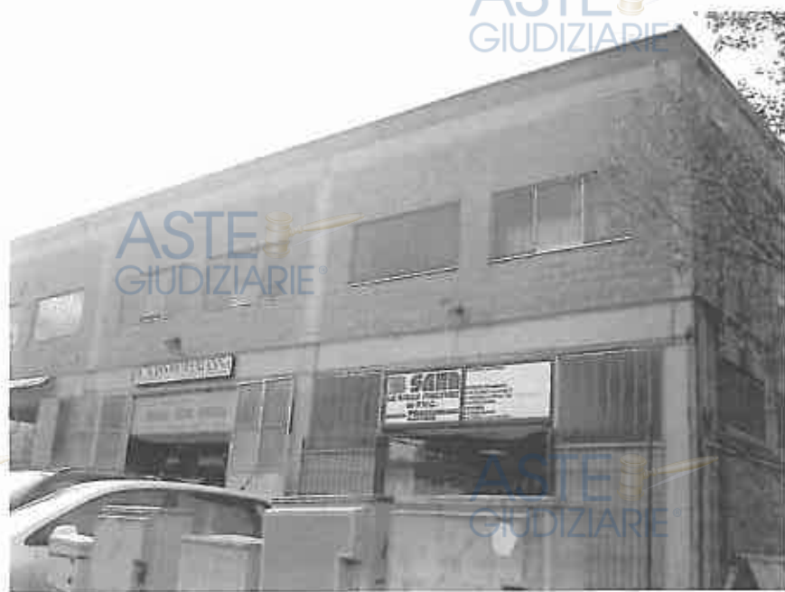
Foto 1 – VISTA PROSPETTO NORD
