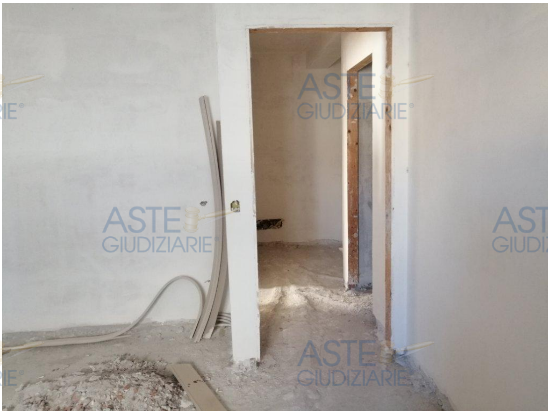
Foto 9 – Zona disimpegno al piano primo.
