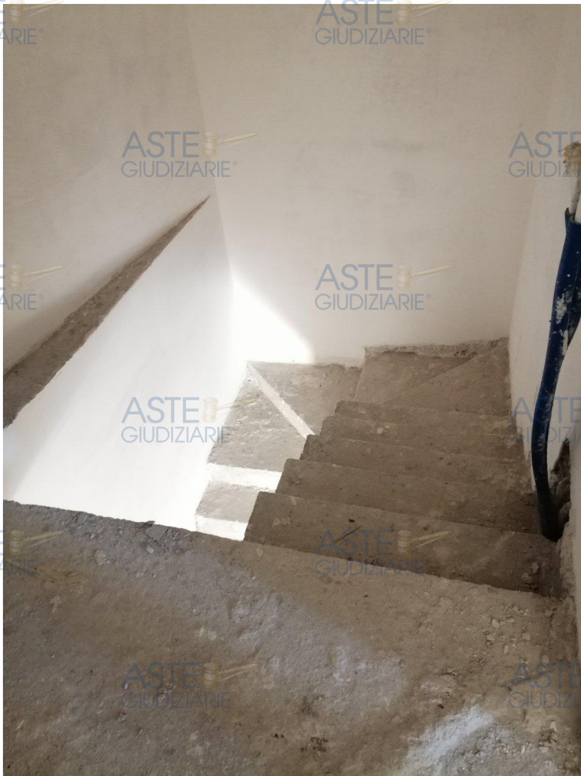
Foto 10 – Vano scala visto dal piano primo.
