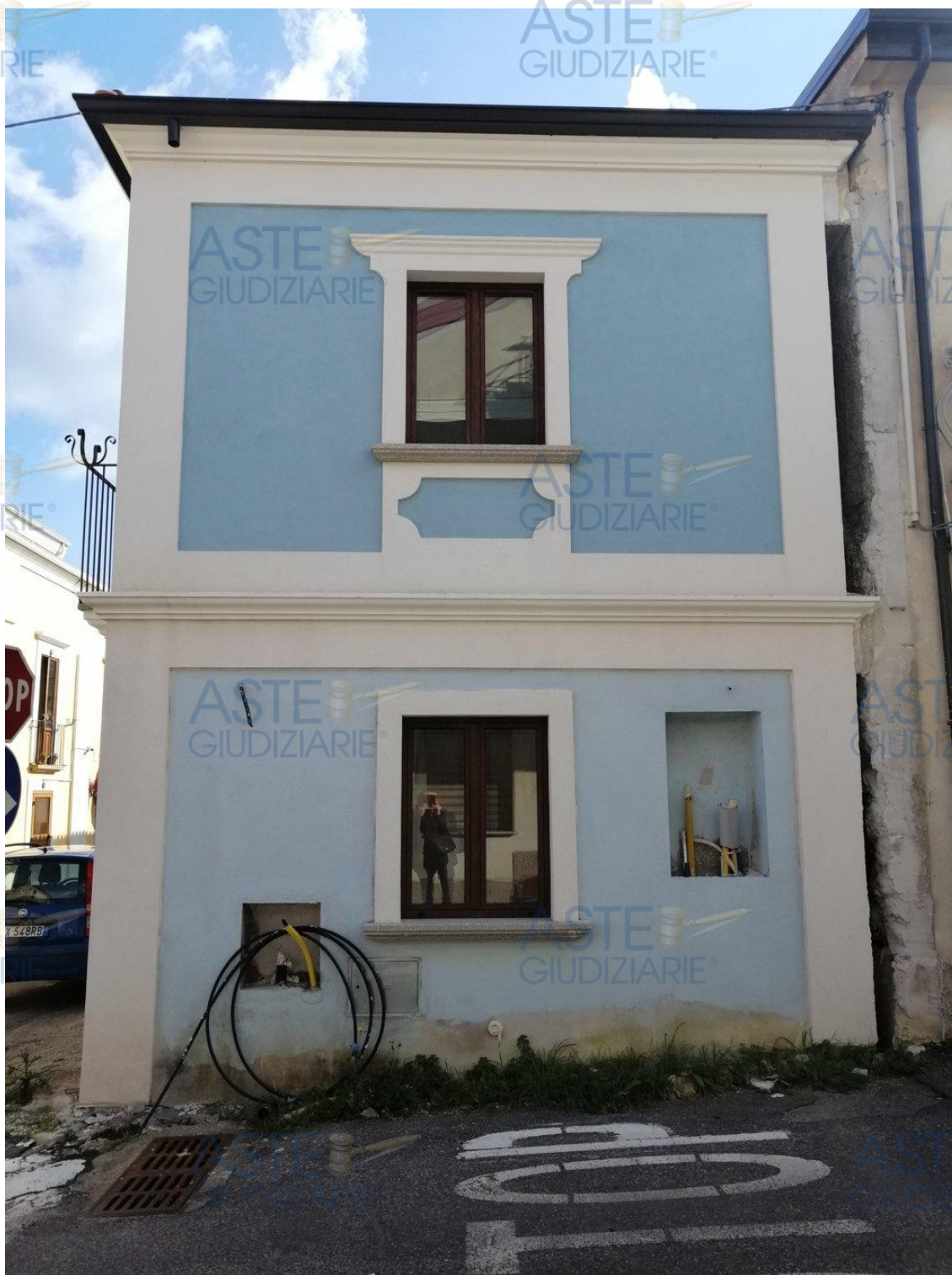
Foto 3 – Vista del fabbricato dalla via Gravazio.
