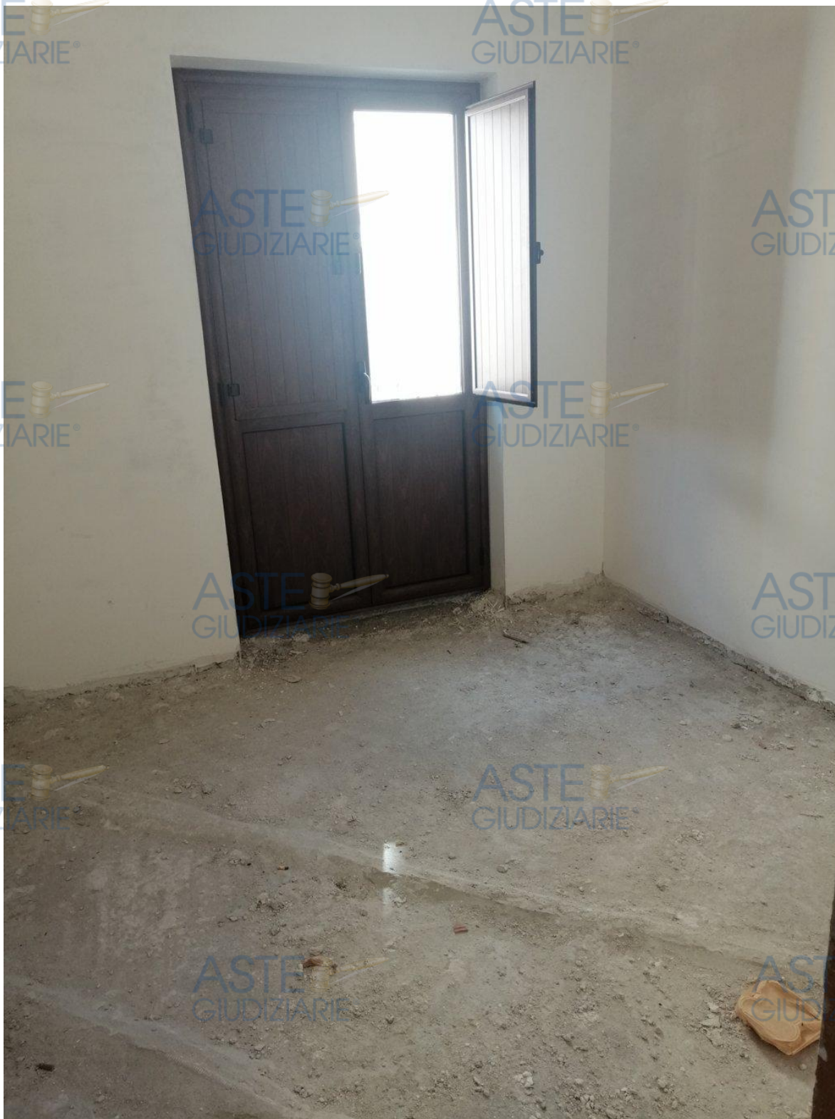
Foto 11 – Secondo ambiente al piano primo.
