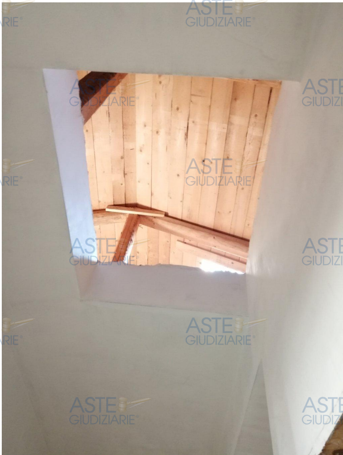
Foto 13 – Locale sottotetto attualmente inaccessibile.
