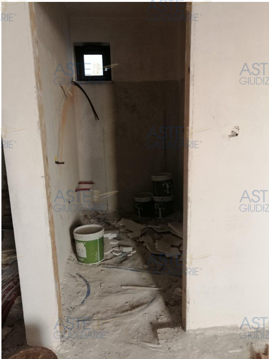
Foto 6 – Secondo ambiente al piano terra.
