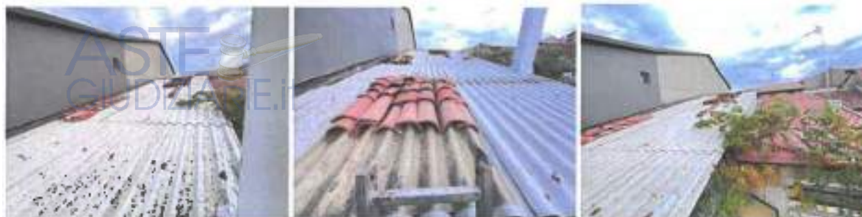
Foto 9-14: Vano sottotetto e tetto
