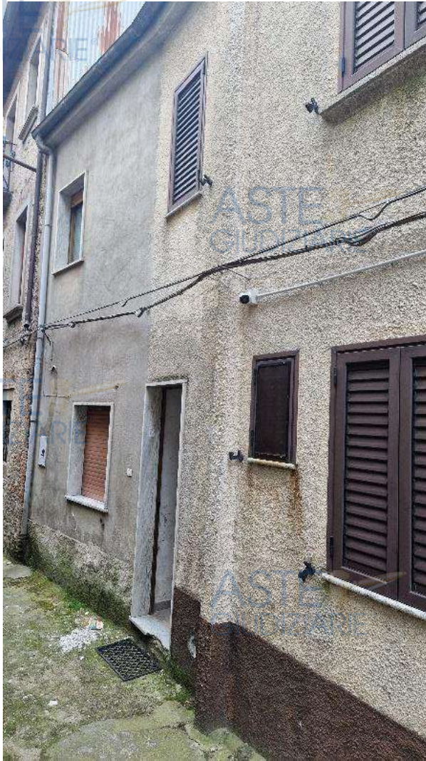
Prospetto frontale su Via Fiume
