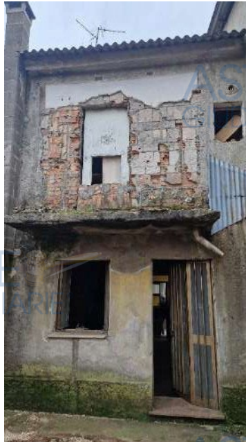
Affaccio immobile in Via Silvio Pellico su proprietà altrui p.lla 851
