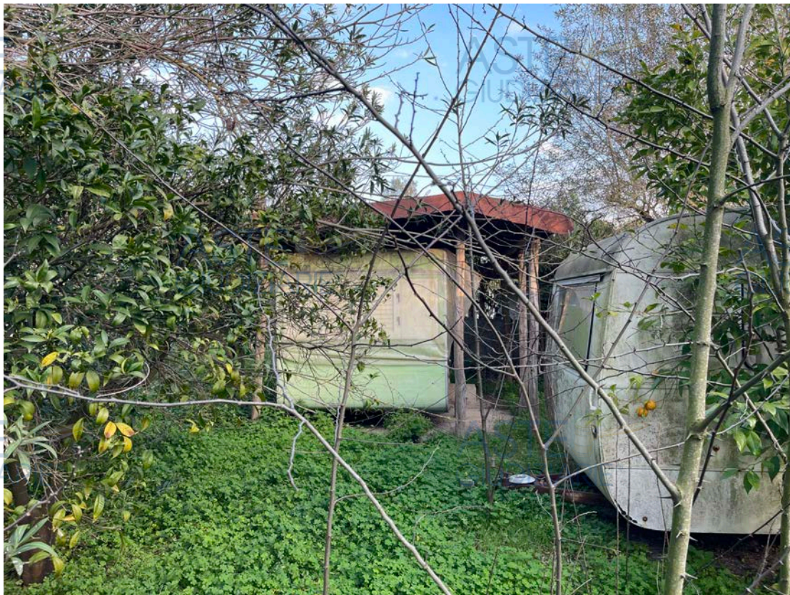
Foto 6 N.C.T. Nicotera fg. 28 - p.lla 555
