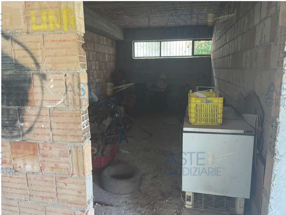
Foto 16 bagno adibito a ripostiglio - fg. 14 - p.lla 443 sub 8
